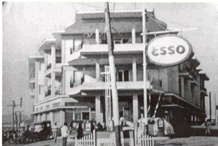
Fotografía III. Edificio de la familia Rodríguez en 1956, situado a la orilla de la Carretera Central del pueblo de Contramaestre, Santiago de Cuba.
