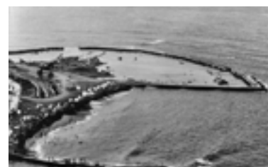
Construcción del Lago Martiánez.
