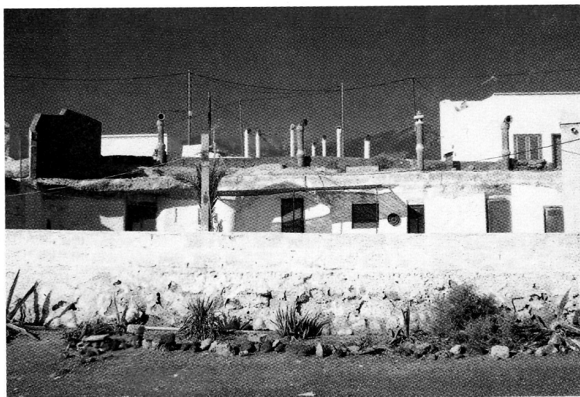
Cuevas habilitadas como viviendas en El Socorro (Güímar). Obsérvese el detalle de las chimeneas que atraviesan el techo lávico de las cuevas y salen al exterior y las ampliaciones realizadas con materiales de construcción habituales.
