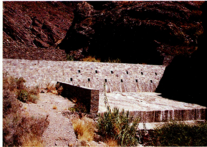
Dique de mampostería hidráulica.
