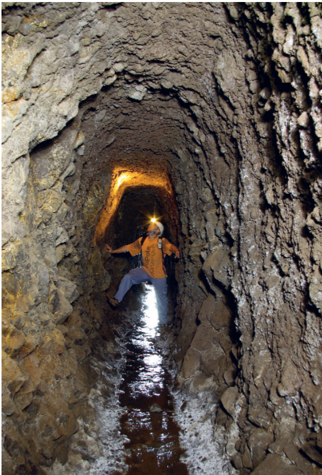
Tramo aguas abajo desde el final de la rampa, donde puede apreciarse la escasa profundidad del agua y el material de conglomerado en que está excavado casi todo este tramo. (Foto: O. Fernández)
