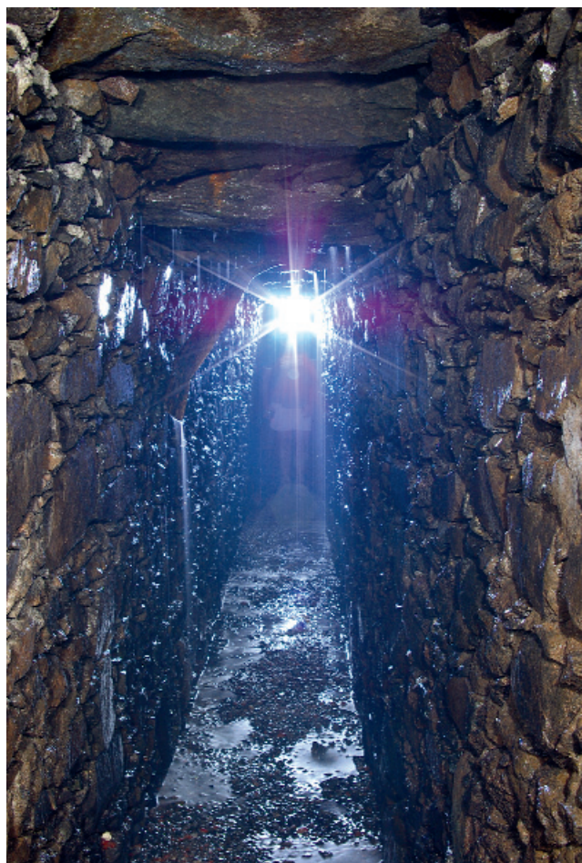
Zona de filtración que aporta el caudal de la mina. Se aprecia el laborioso entibado que protege la galería de los desprendimientos. (Foto: O. Fernández)
