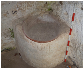
Detalle de lebrillo embutido en poyo. Lugarejos. Foto: autor. 2011.
