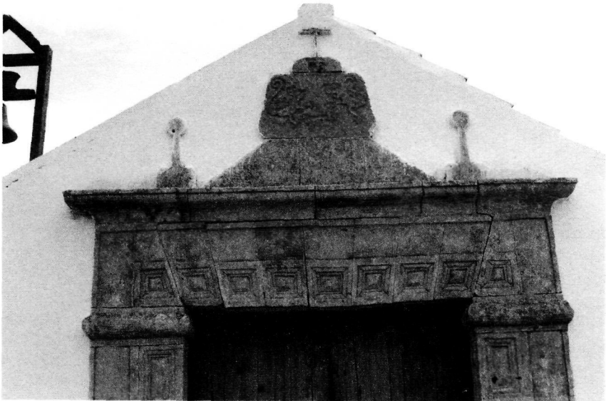
Detalle de la fachada principal.
