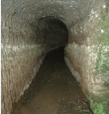
Acequia y túnel de la Mina de Tejeda. Foto cedida por Francisco Suárez Moreno.
