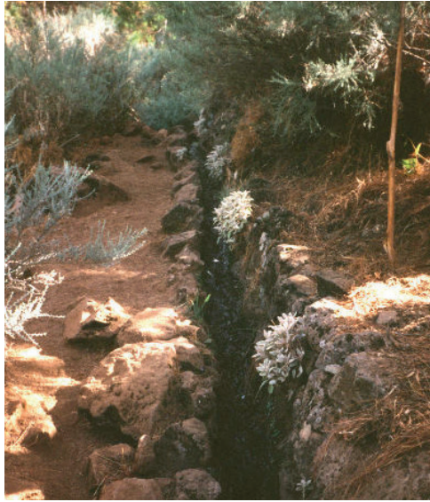
Acequia a cielo abierto, excavada entre la tierra y la roca. FEDAC
