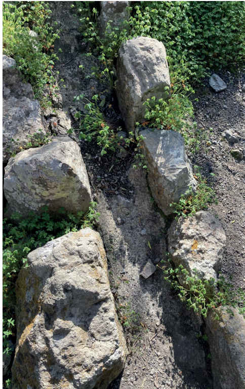
Acequia de la caldera de Bandama, ejecutada con argamasa y piedra. Foto del autor.
