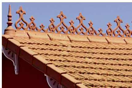
Cubierta típica de un edificio ecléctico, con sus tejas francesas y sus crecerías de barro cocido.
