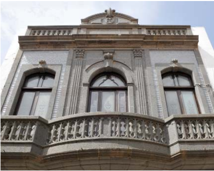
Detalle de una fachada ecléctica (vidrio, piedra, azulejos) de un inmueble histórico de Santa María de Guía.
