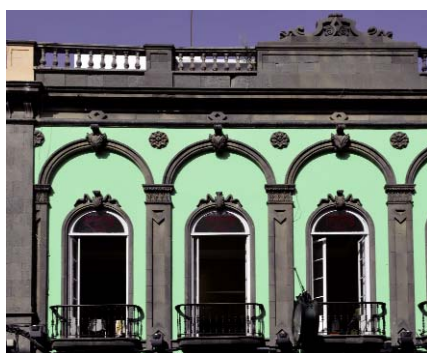
Detalle de los arcos que definen la fachada de la Casa de Blas Rodríguez Suárez. Manuel Ponce de León, 1868. Las Palmas de Gran Canaria.
