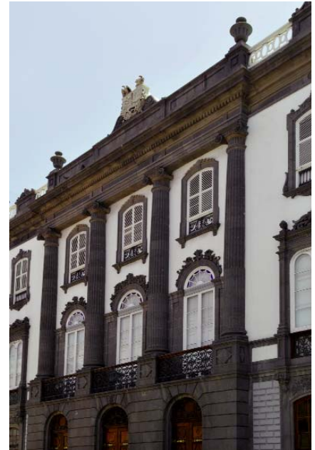
Detalle de las cuatro columnas de la Casa Llarena que forman el elemento de tensión de su fachada. Manuel Ponce de León. 1859. Las Palmas de Gran Canaria.
