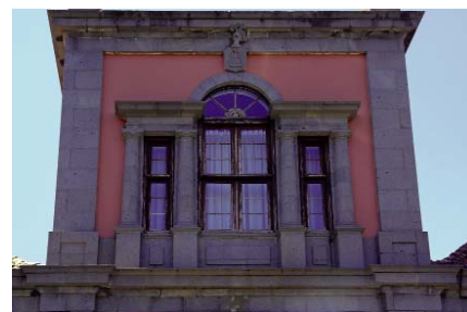
La ventana serliana constituyó un elemento recuperado por la arquitectura académica del siglo XIX.
