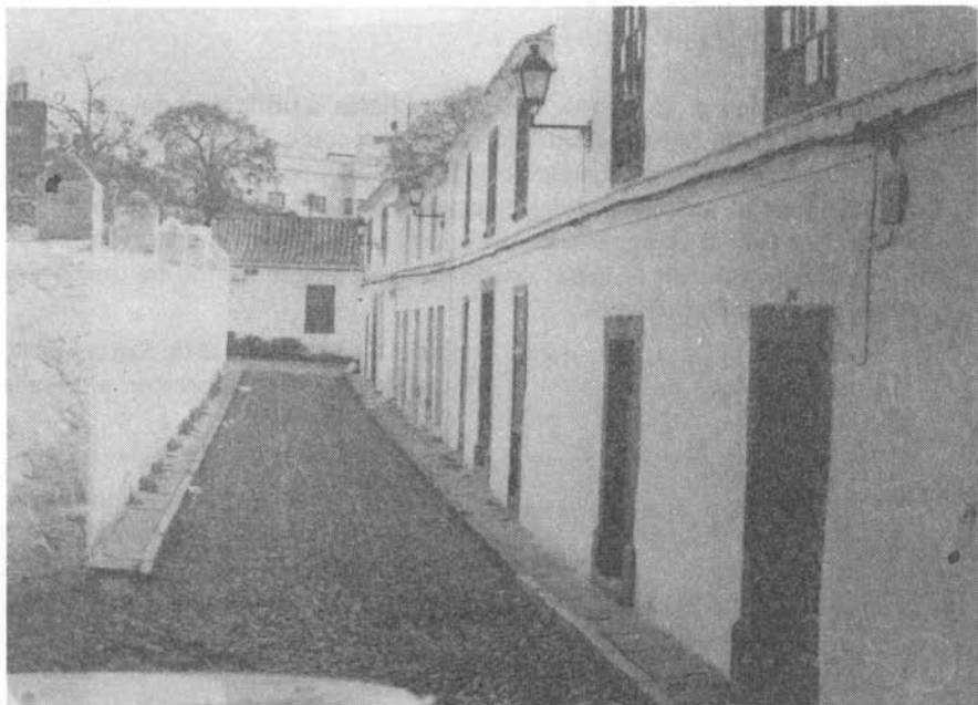
Barrio de San Francisco, antes de Santa María. Sus calles en cuesta, estrechas y sinuosas, siguen siendo fieles a su primitivo trazado.
