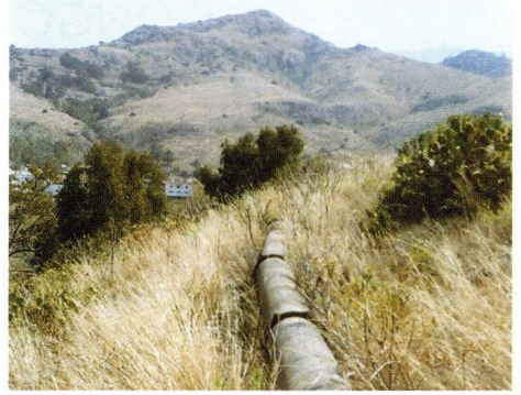
Cantidad y variedad de tuberías.
