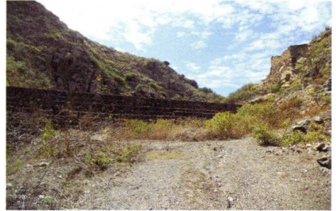
Pequeña presa en "La Cantera".
