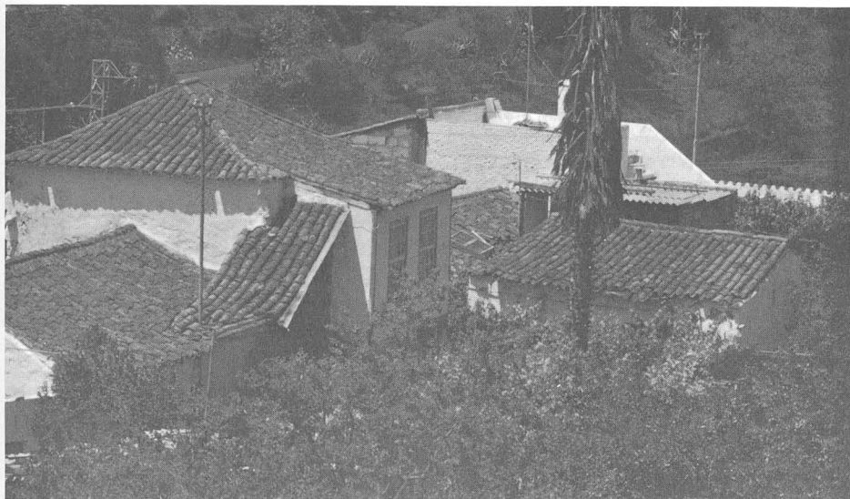
Construcción tradicional en San Mateo (Gran Canaria)
