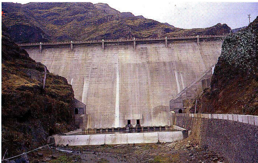
Presa de Chejelipes en La Gomera.
