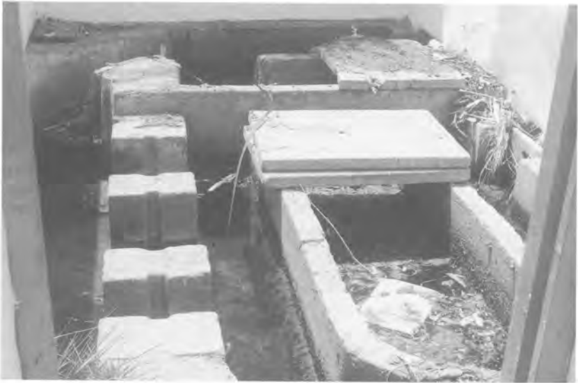
Cantonera del reparto de las aguas de la Heredad de El Valle de Los Nueve, situada en el estanque de García, en Los Ramírez. Verdadera obra rústica de ingeniería, calibradoras del caudal de agua.
