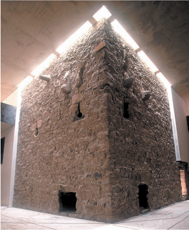
■ FIGURA 3. Fachadas este y sur de la Torre, con dos cañoneras en la planta baja y tres troneras en la primera planta
