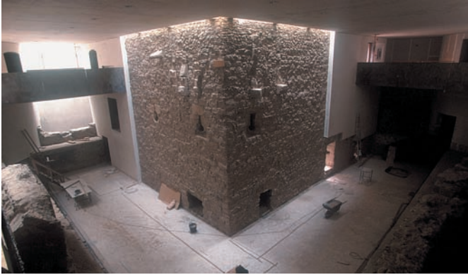
■ La Torre de Alonso de Fajardo durante los trabajos de rehabilitación
