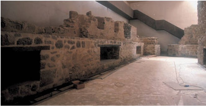
■ La Barrera Artillera (1548-1553) después de las obras de rehabilitación
