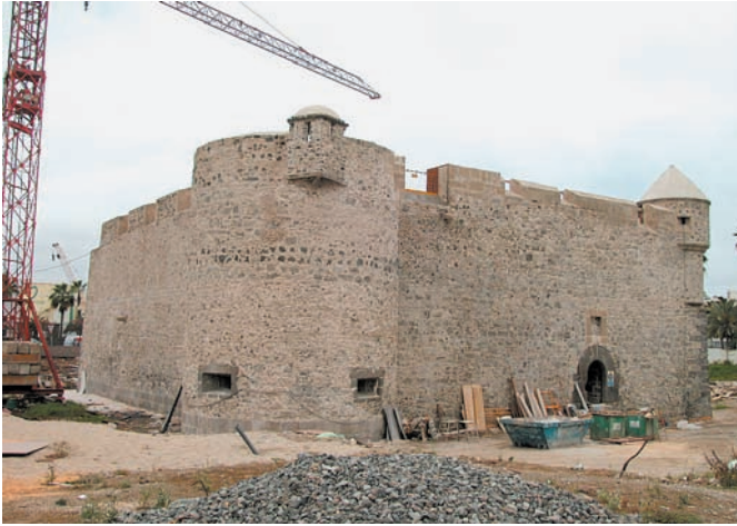
■ Exterior del Castillo de La Luz. En primer plano el cubelo norte con sus troneras altas y bajas
