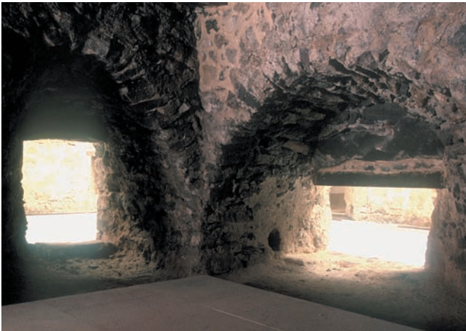
■ FIGURA 4. Cámaras de tiro de la planta baja de la Torre de Alonso de Fajardo. Siglo XV.
