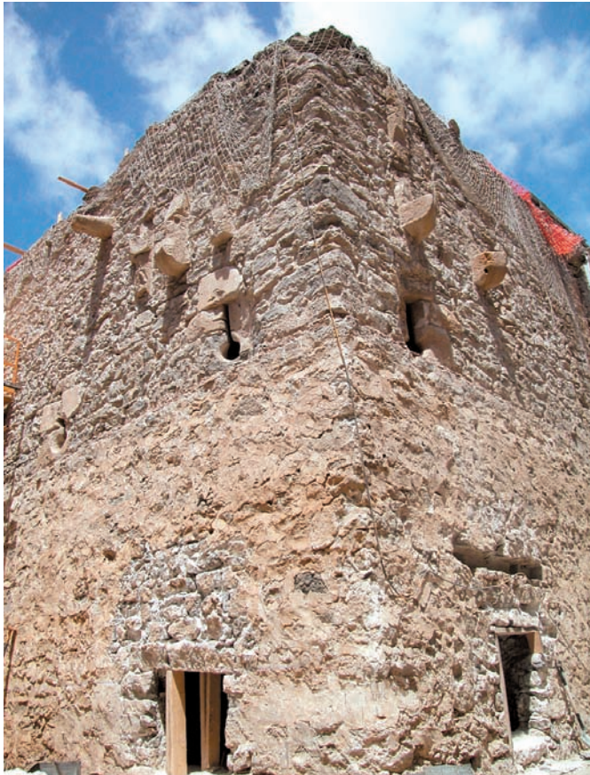
■ La Torre de Alonso de Fajardo durante los trabajos de rehabilitación de 2001
