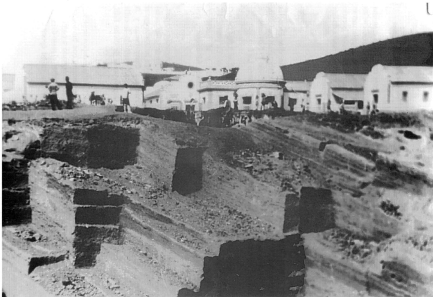
Foto N°. 19.- C.P. Franchy y Roca. El Colegio desde la cantera que hubo delante de dicho Centro. (1931) (4)
