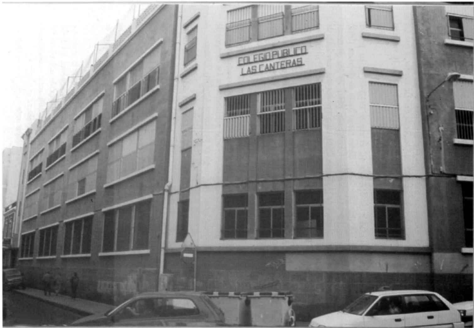
Foto nº. 28.- C.P. Las Canteras. Fachada Sur. (4)
