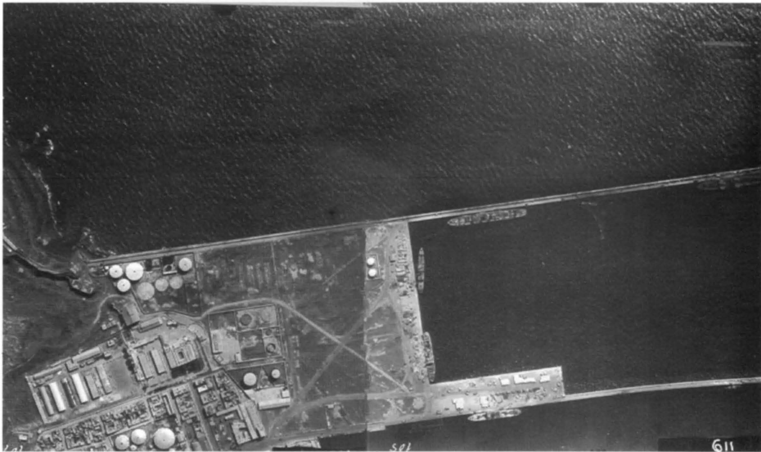
Foto Nº. 9.- Obras del "Ensanche" del Puerto de La Luz. Década 1940. (1)
