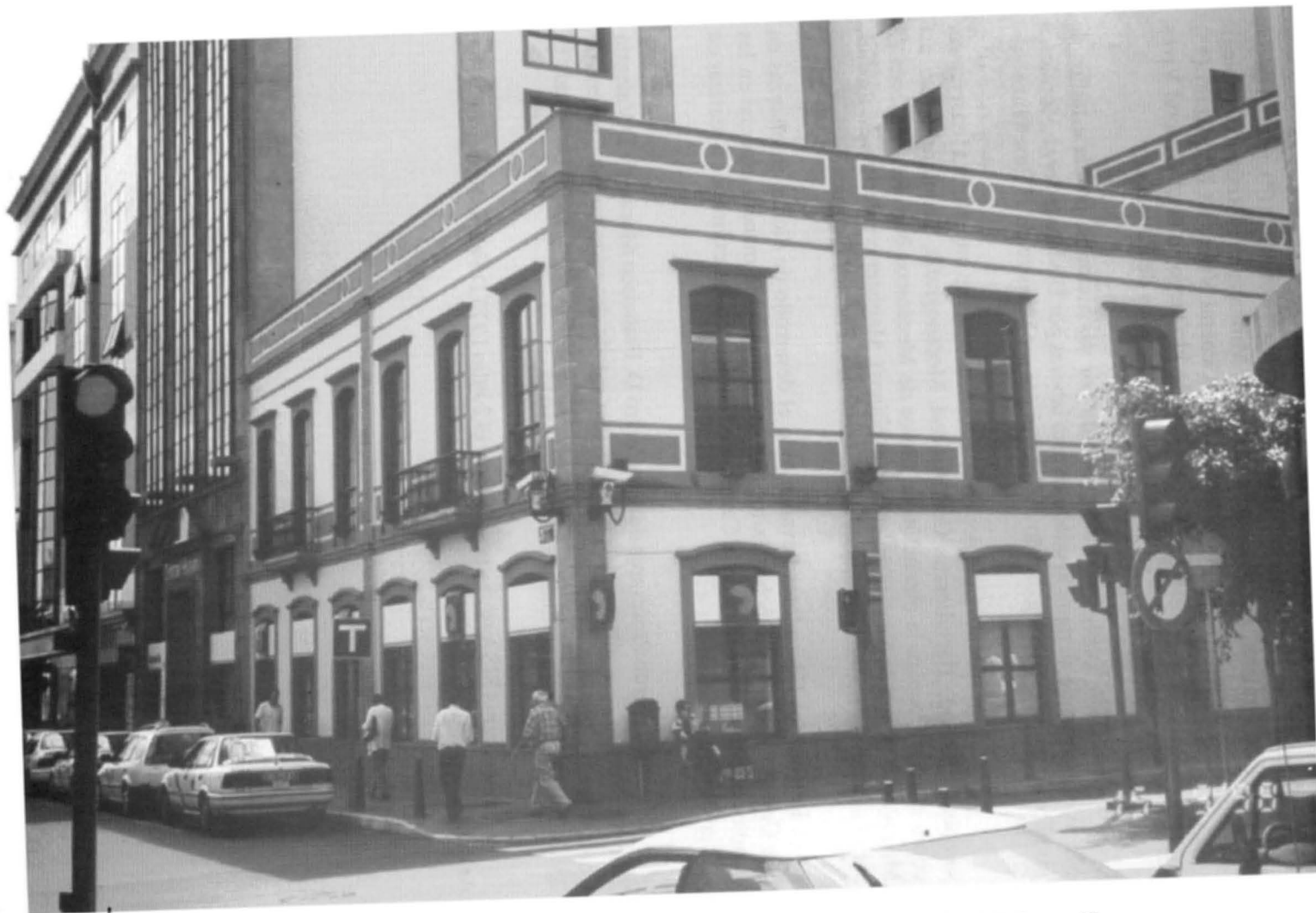
Foto N°. 80.- Colegio Sarmiento. Edificio donde estuvo el Centro. c/.General Vives, esquina Nicolás Estévez. (4)
