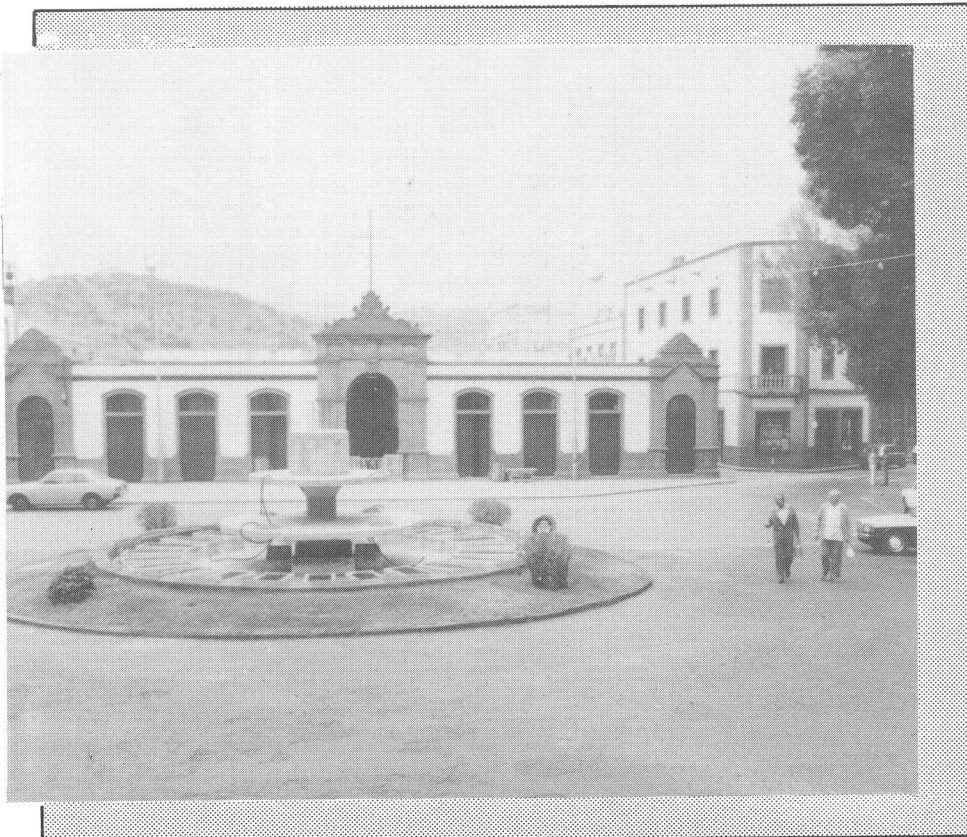
Foto 3. El Mercado de Echegarreta, a punto de concluidas las obras de remodelación interior, de las que ha sido objeto recientemente.
