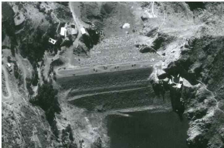
El macizo de la Presa de Tirajana y su aliviadero Morning Glory
