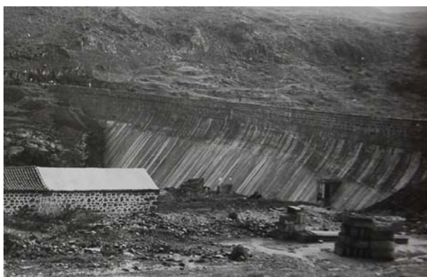
Presa de Chira
