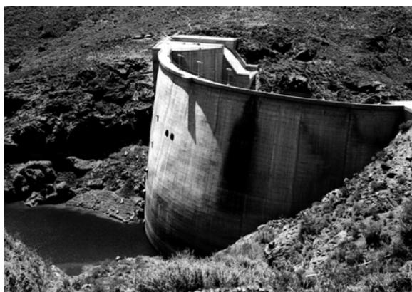
Presa de Soria
