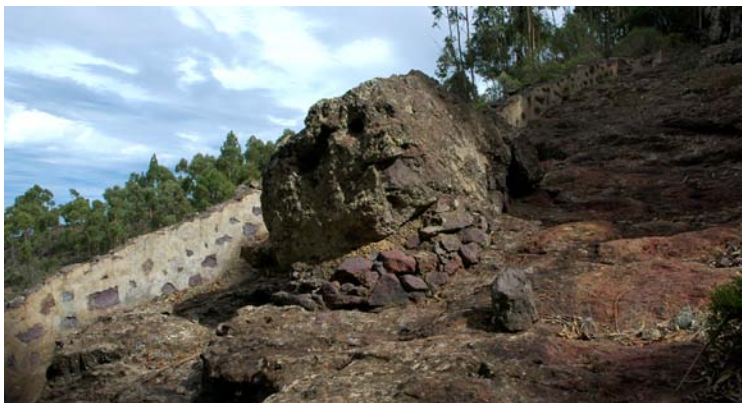
La piedra del canal de descarga de la Presa de Tamadaba
