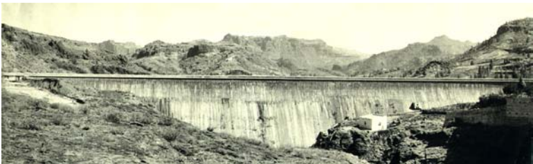
Presa de Chira
