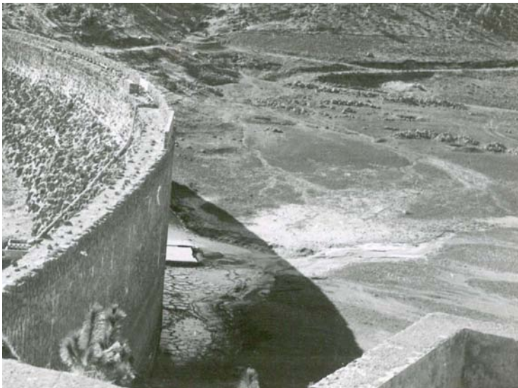
Presa de Cuevas Blancas (1964). La tradición oral recoge que el hormigón inyectado a esta presa salía por los manantiales de Tirajana.
