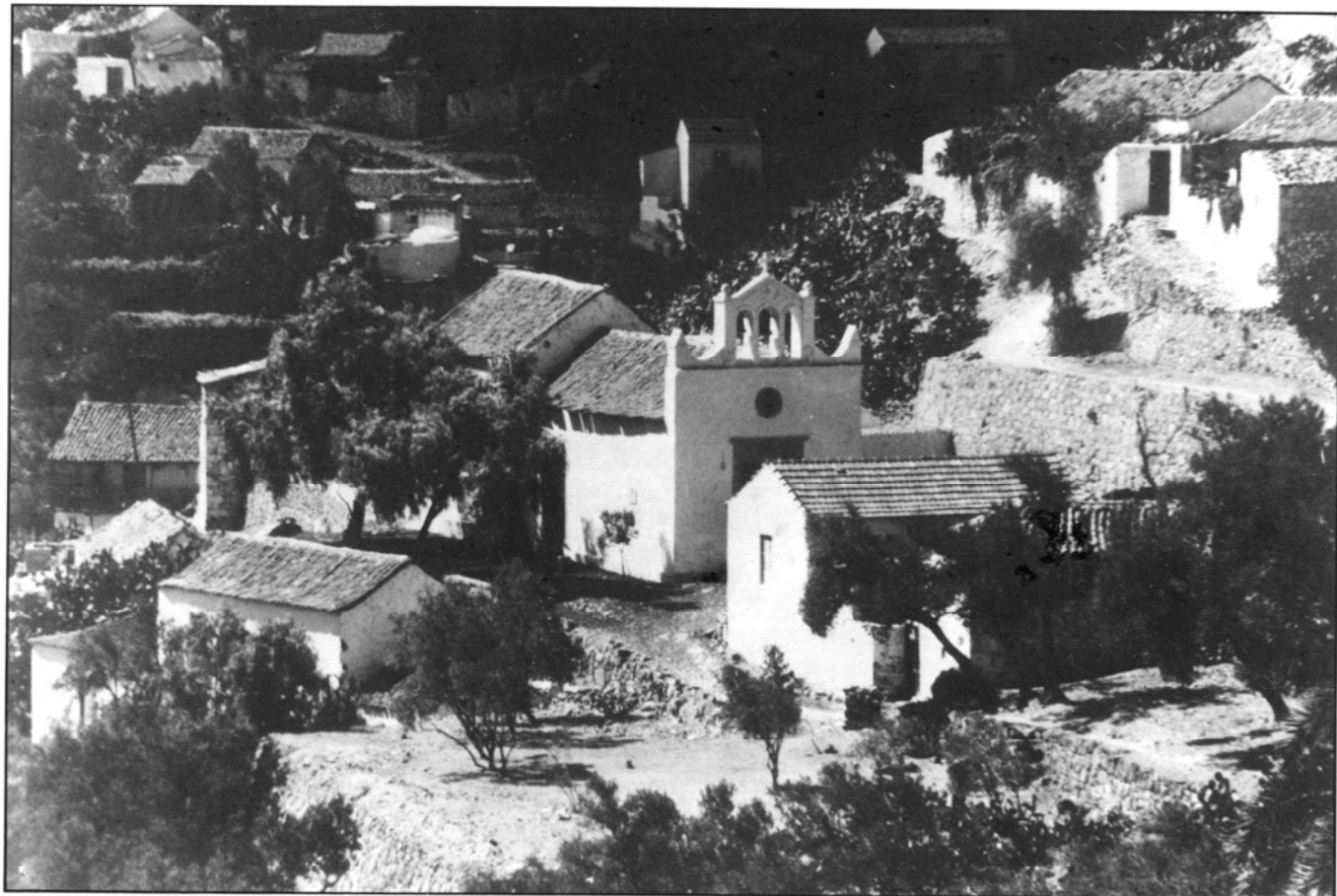
Iglesia y casas con tejados a dos aguas. Barrio de Temisas.
