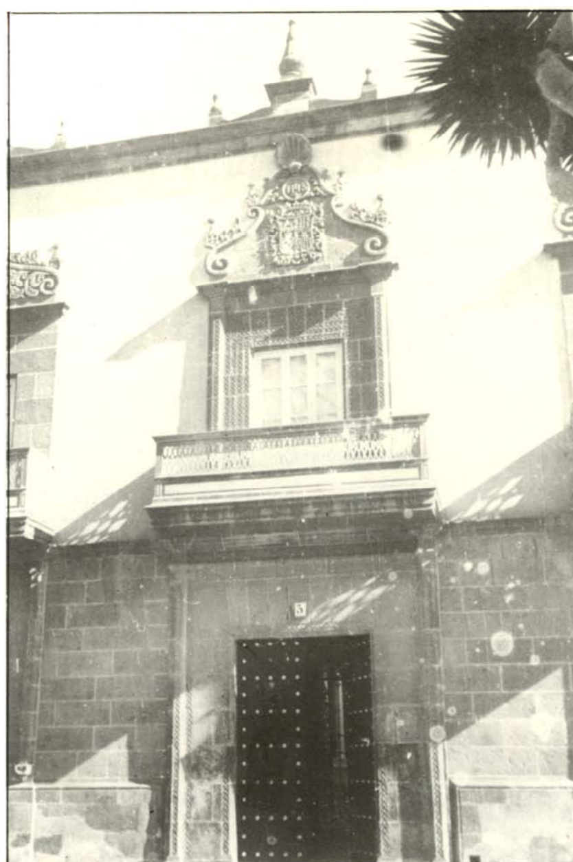
Casa señorial de Vegueta, rica en piedra y balcón de madera y hierro fundido.
