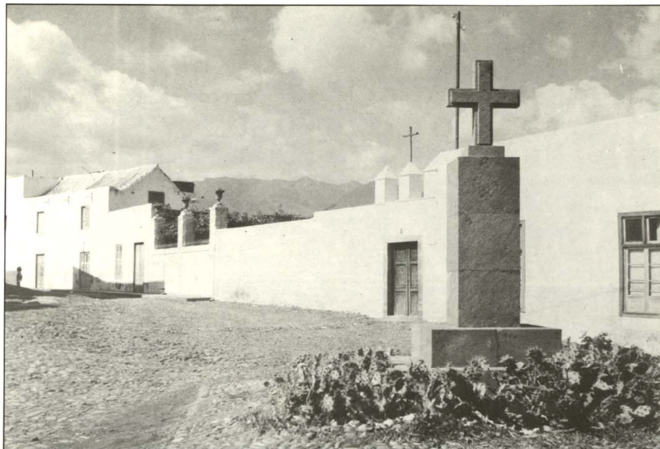
Empedrado en calle, muros de cerca. Barrio de San Francisco - Telde.
