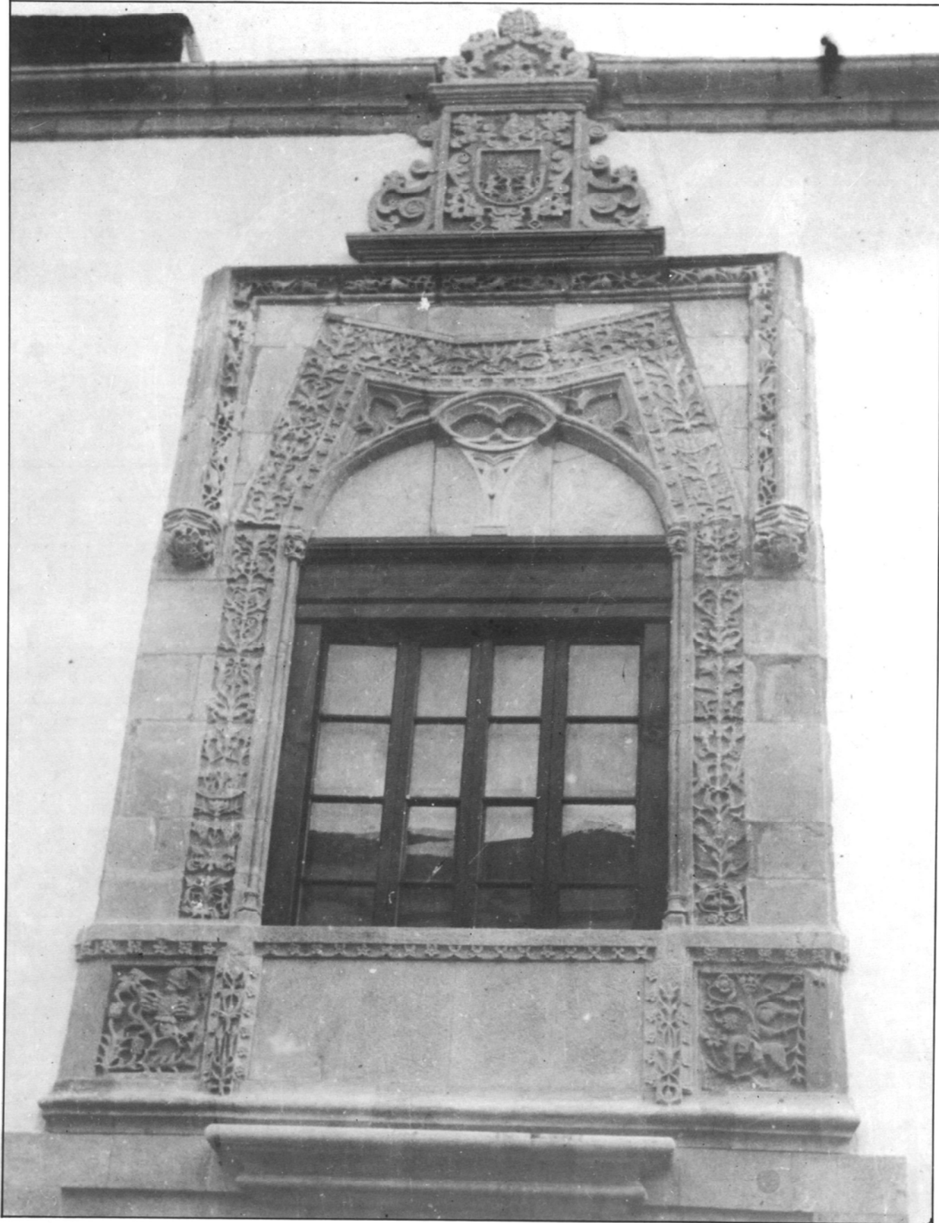
Cuerpo alto de la portada principal de una vivienda histórica de la Calle de Los Balcones, labrada en piedra de arenisca, extraída de la costa de la ciudad de Las Palmas de Gran Canaria.
