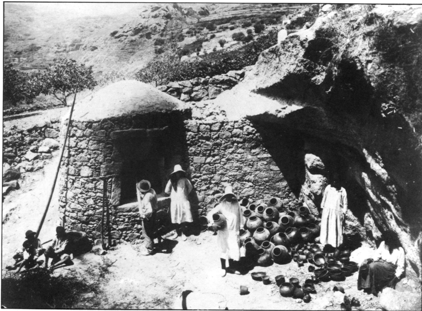
Técnica de piedra seca en pared, horno de alfarería y bóveda de barro - La Atalaya.
