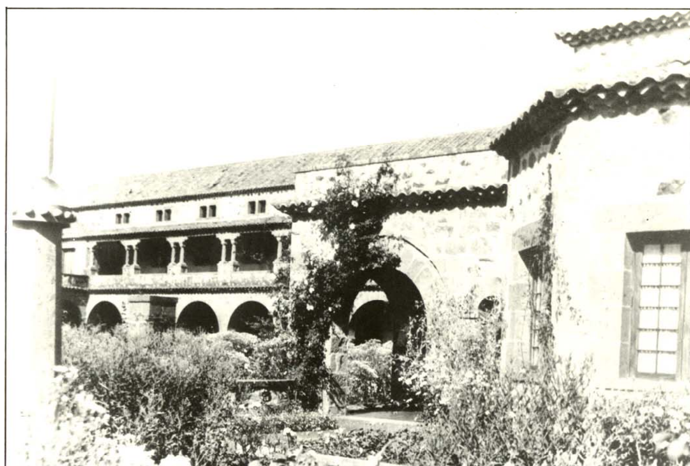
Construcción en piedra vista -ver corredor aporcado-. Dominicas - Teror. (De D. Laureano de Armas).
