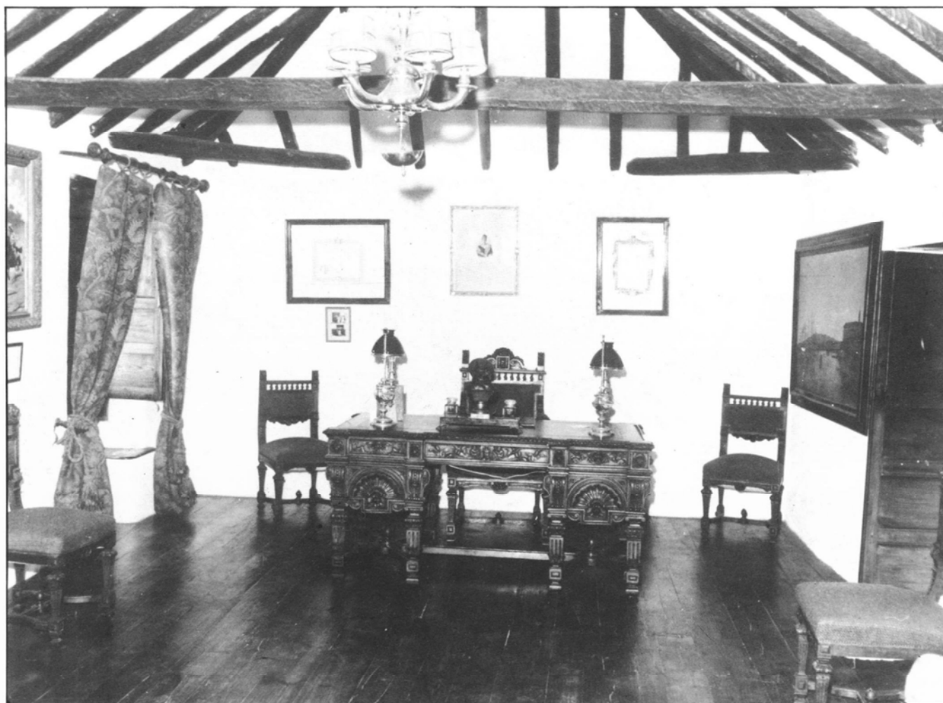
Solución de estructura en madera y pavimento en tablas de tea. Interior de la casa de León y Castillo - Telde.
