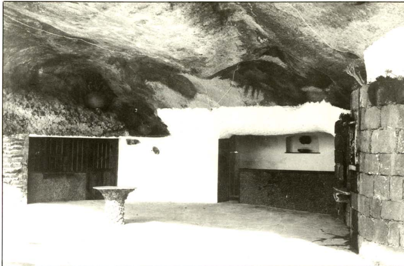
Bar "LA SILLA" labrado en el solapón del risco a la entrada del túnel de acceso al restaurante. Pared en sillares volcánicos rojos.
