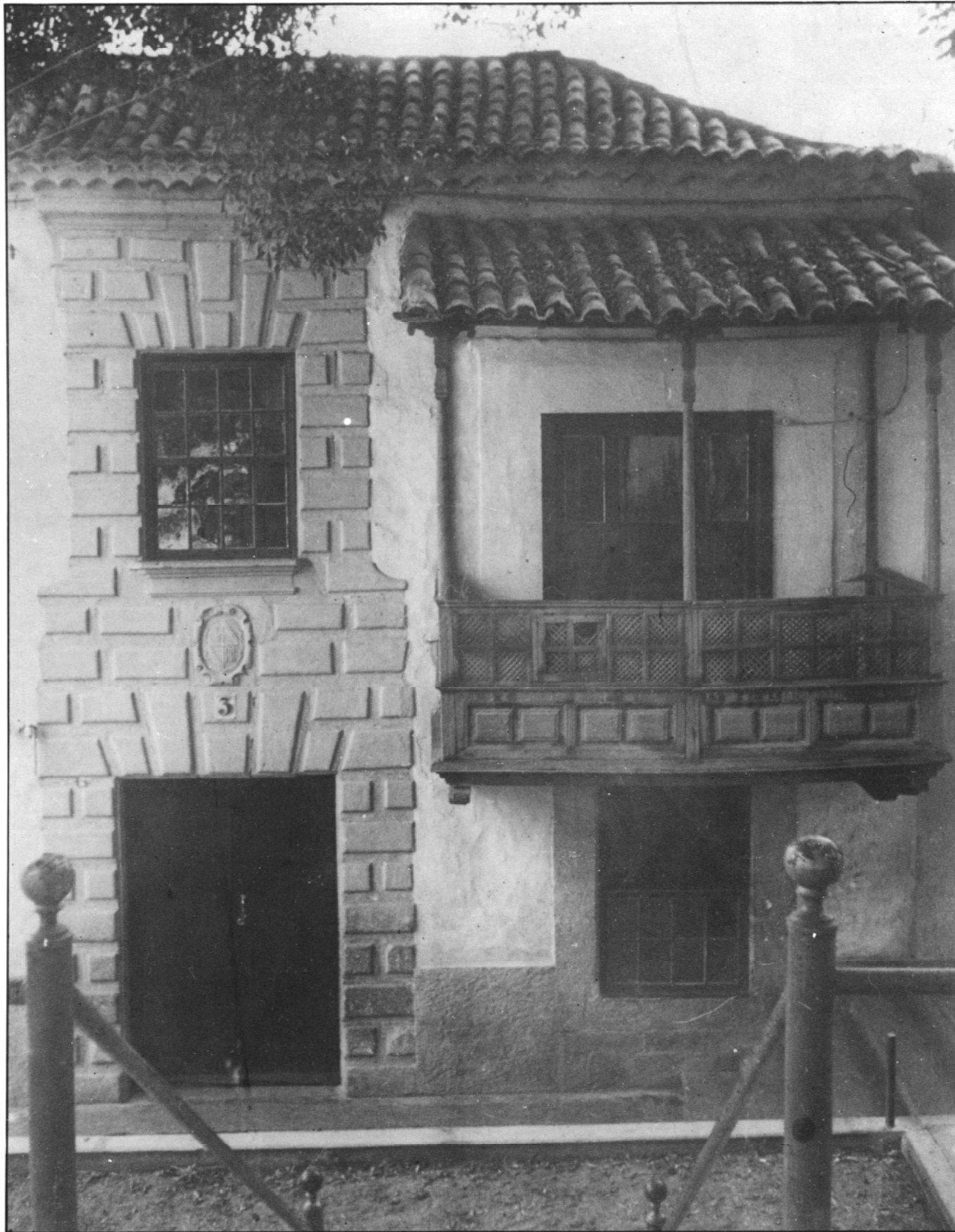
Puerta de cantería almohadillada en San Juan - Telde.
