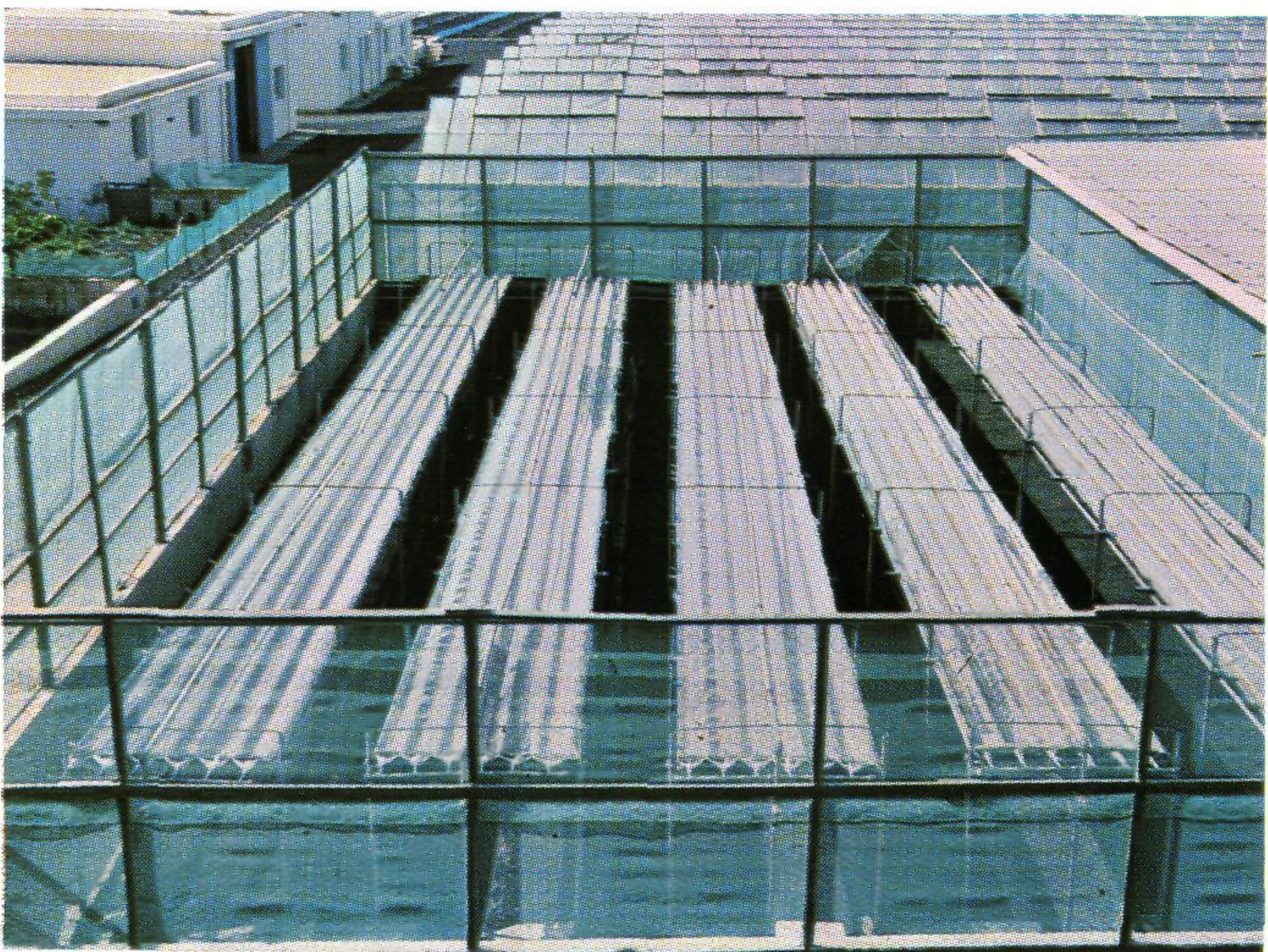
7— Vista general de la instalación existente en la Planta Hidropónica de Lanzarote.
