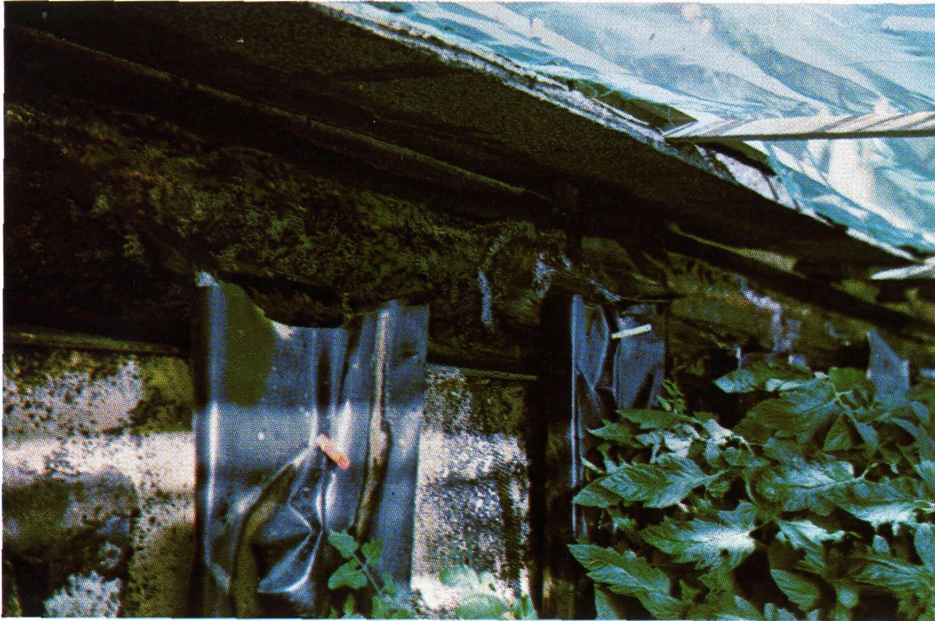
12— Detalle del colector.
