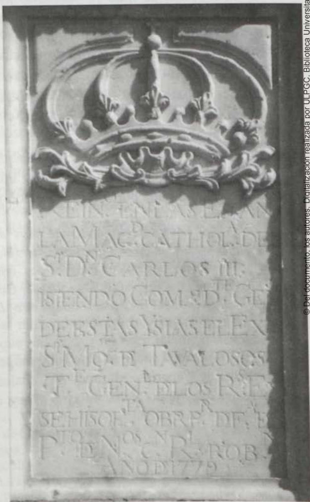
Placa conmemorativa de la construcción del castillo en 1779.
