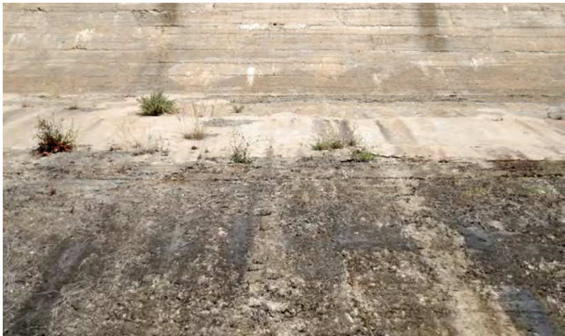
Detalle del paramento del talud aguas abajo de la presa (Foto JG)
