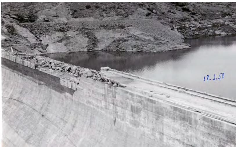
Finalizando la construcción de la Presa de las Niñas (Enero de 1958)
