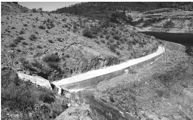
El canal del aliviadero de la presa
