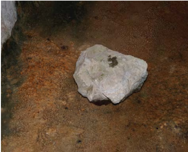
Mampuesto desprendido del muro (Foto JG) (interior de una de las galerías transversales)
