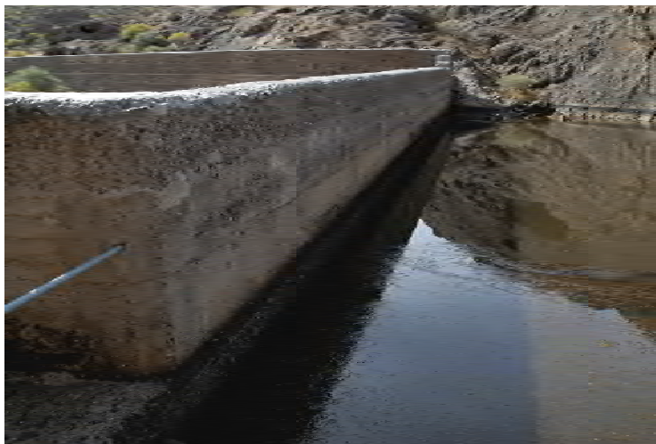
Detalle de un tomadero de mampostería (Foto JG)
