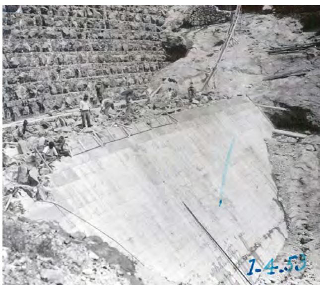
Trabajando en el muro de presa (obras de la tercera etapa) (Fotos Comunidad de Regantes de la Presa de la Cueva de las Niñas)
