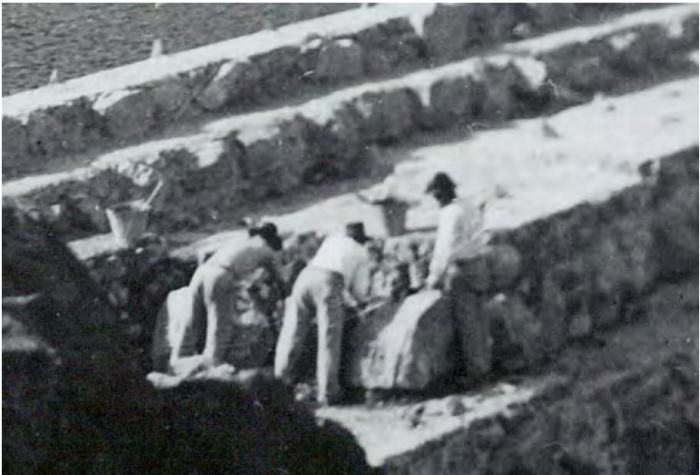
Detalle de la construcción del muro hasta los 22 metros (Fotos Comunidad de Regantes de la Presa de la Cueva de las Niñas)
