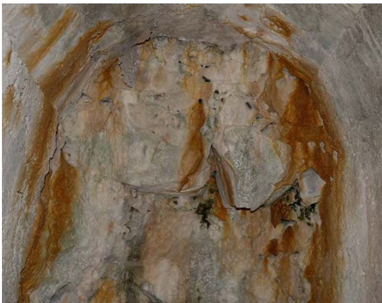
Contacto entre el muro antiguo a 22 m y el muro moderno a 32 m (Foto JG)
