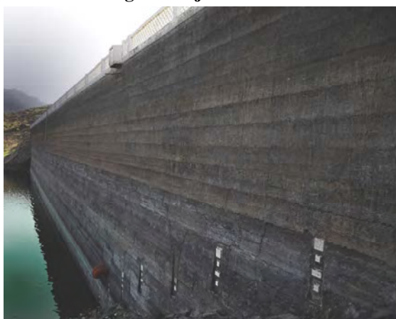
Paramento de aguas arriba (Fotos JG)
