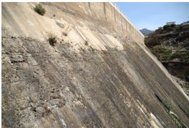
Paramento de aguas abajo de la Presa de las Niñas
