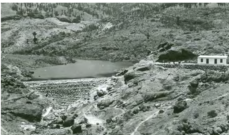
Presa de las Niñas (muro de presa con 22 metros de altura)
