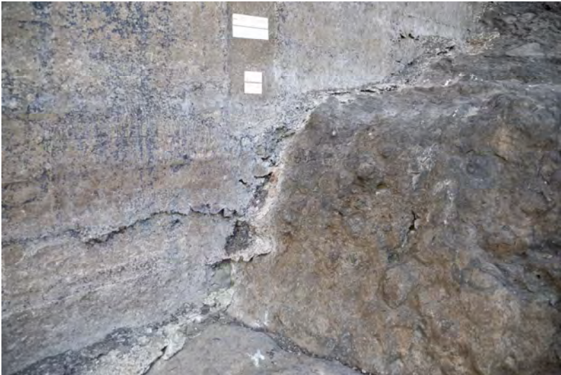
Detalle del contacto obra y terreno (Hormigón y Brecha Roque Nublo) (Foto Jaime González)
