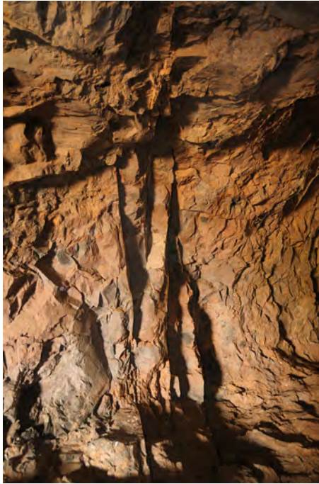
Detalle de una diaclasa existente en el terreno (interior del túnel)
