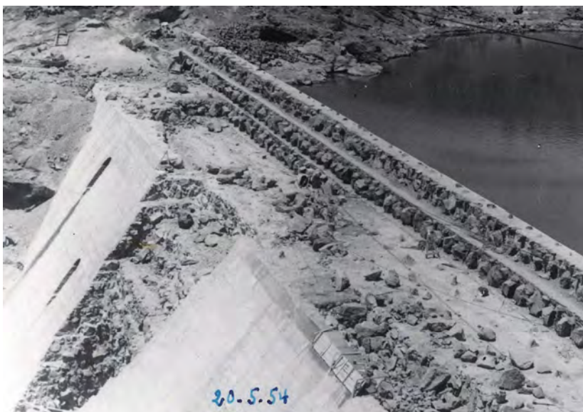
Vista de los dos muros de la Presa de las Niñas (Fotos Comunidad de Regantes de la Presa de la Cueva de las Niñas)
