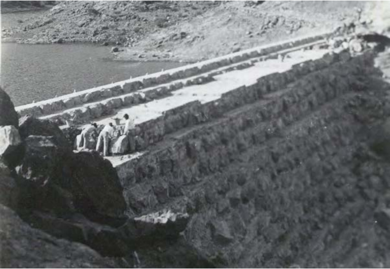
El muro de la Presa de las Niñas de la segunda etapa constructiva
