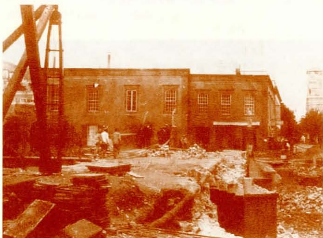
Demolición del viejo puente de piedra en 1927.
