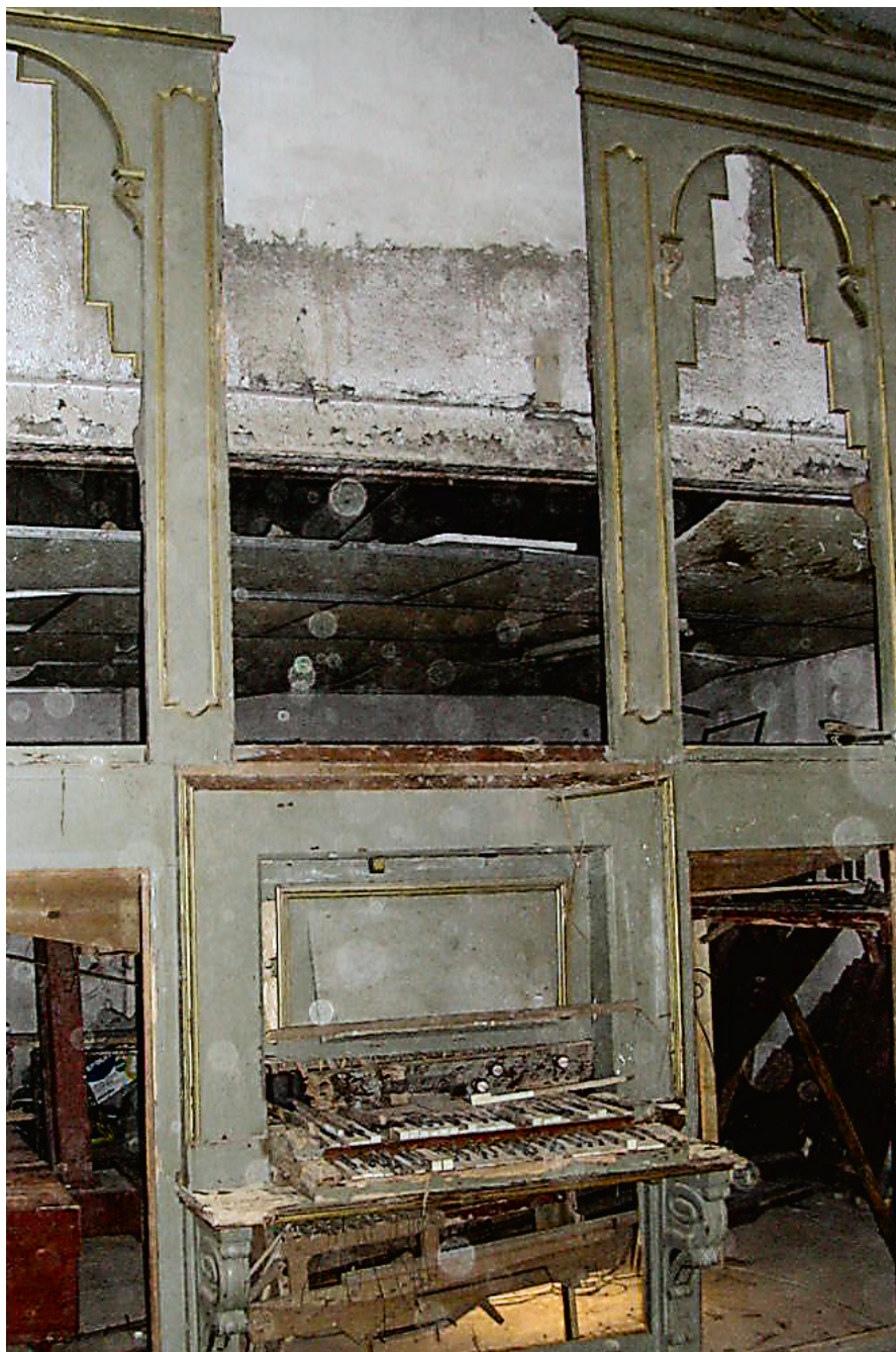
■ Montaje previo de piezas deterioradas del mueble y consola
