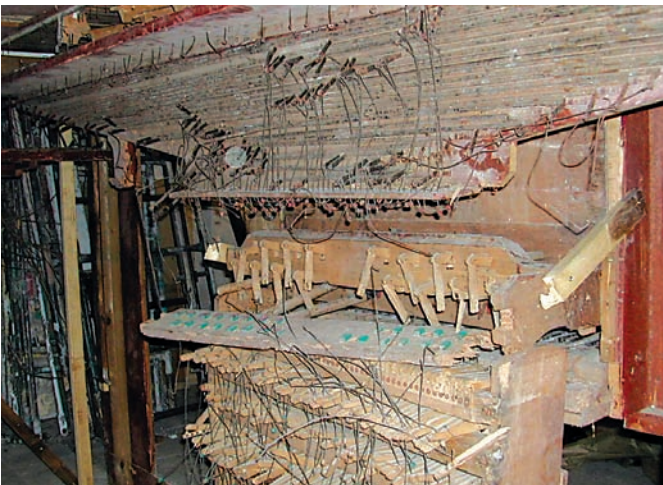
■ Mecánica de reducción de notas, tiradores de registros y balancines de acoplamiento, (estado previo)
