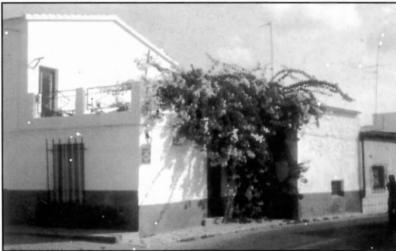
Foto 6: La mejor protección proporcionada es el patio de una vivienda; aquí con exuberancia de una Bougainvillea multicolor
