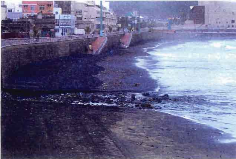
Figura 15. Escorrentías del barranco de la Ballena en febrero de 2005, drenando los materiales arrastrados directamente en la playa de Las Canteras.
