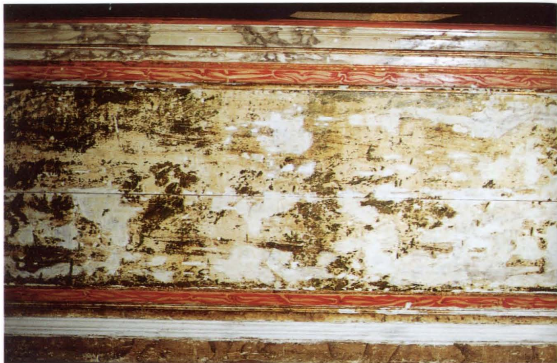
Proceso de restauración. Estucado del frontal del Altar y restos de policromía.
