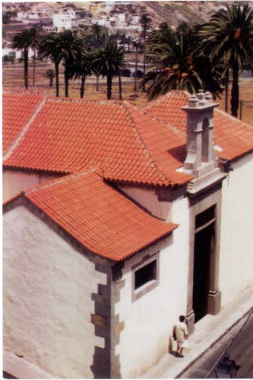
Iglesia de San Pedro Mártir con la techumbre y la espadaña restauradas.
