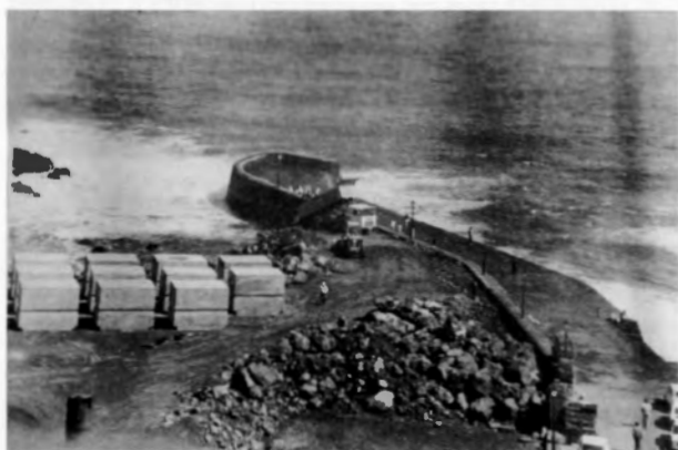
Trabajo de ampliación del muelle.
