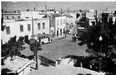
La plaza de San Gregorio y la calle General Franco vistas desde la Iglesia de Los Llanos, Obsérvese en el pavimento renovado, de color más oscuro, toda la superficie cedida a lo vía pública para mejorar el tráfico en la ruta del Sur de la Isla
