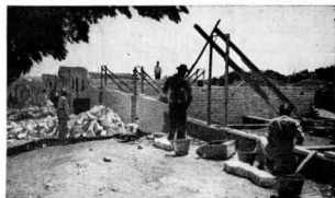
Obras en construcción de las viviendas
