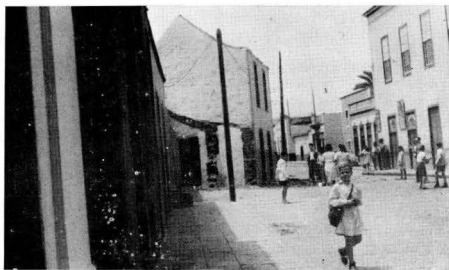
Calle Rivero Bethencourt antes de efectuarse la expropiación de los inmuebles que aparecen en la fotografía, interceptando el tráfico con una estrangulación de cinco metros
