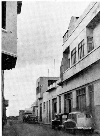
Calle Navarra casi totalmente edificada en ambos lados. Obsérvese la perfección de las alineaciones y pavimento.
