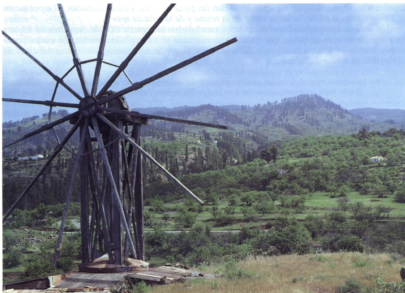
Fig. 6. —Buena parte de la artesanía y arquitectura tradicional se ha alimentado de la madera del pino canario. Molino de Las Tri-cias, Garafía.
