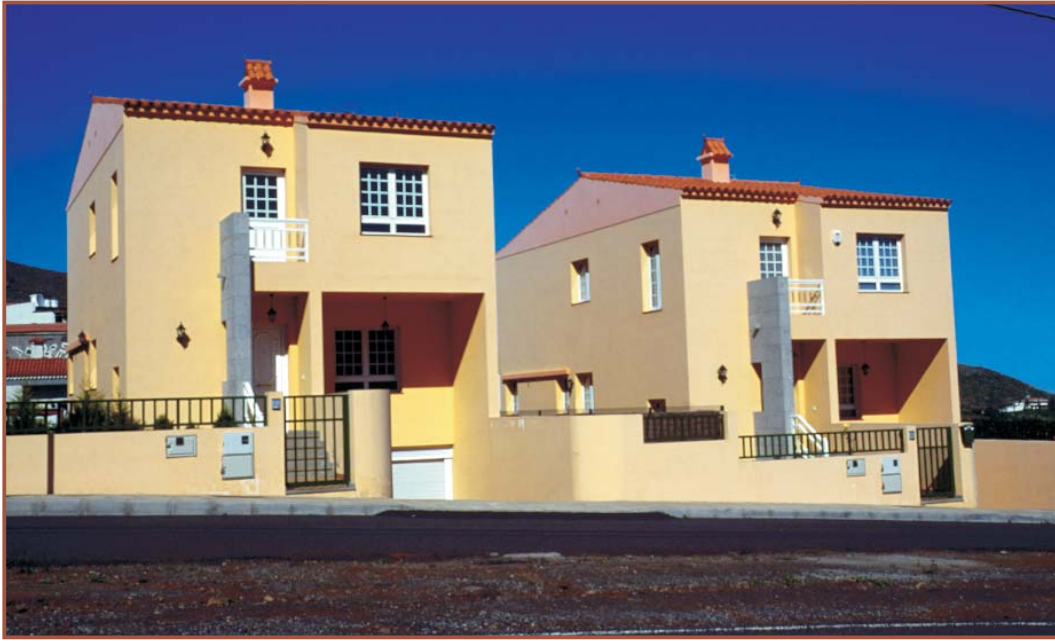
Foto 11.- Los Llanetes. Viviendas adosadas de tipo dúplex en la carretera general.
