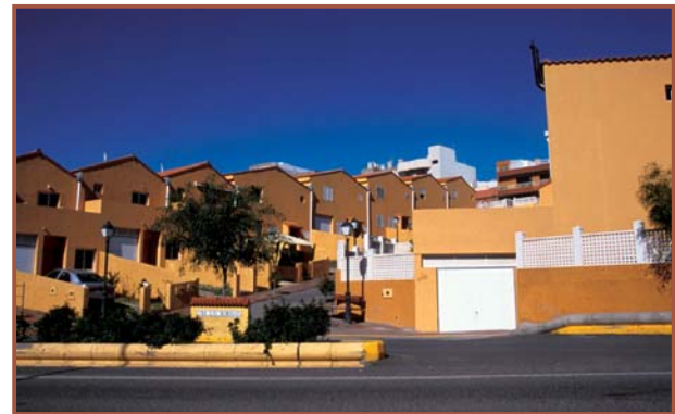
Foto 24.- La Barrera. Promoción de viviendas adosadas en La Barrera.
