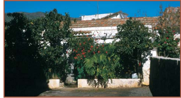
Foto 15.- Casa en las Vegas. La antigua latada de madera se ha sustituido por tuberías de plástico. Algunos frutales y otras flores de patio, dan vistosidad y sombra al mismo.
