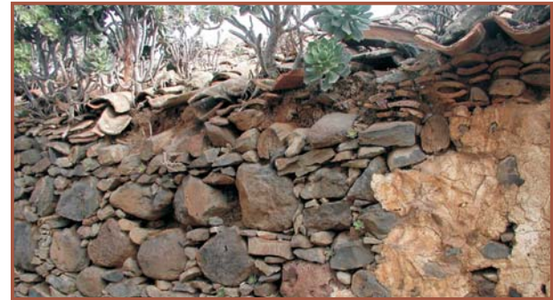
Foto 16.- Detalle de materiales constructivos. En esta fotografía de las ruinas de una vivienda rural en las proximidades de Las Vegas se aprecia la teja de las gruesas vigas maestras a las que se anclaban las de cubierta.
