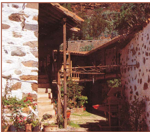
Foto 19.- Cuartel del Colmenar. Corredor.
