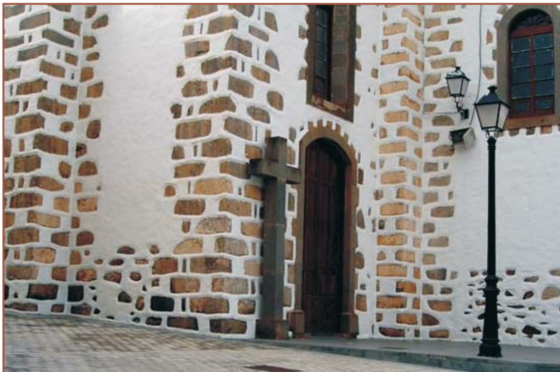
Foto 1.- Iglesia de San Miguel. Lateral izquierdo, vista frontal.
