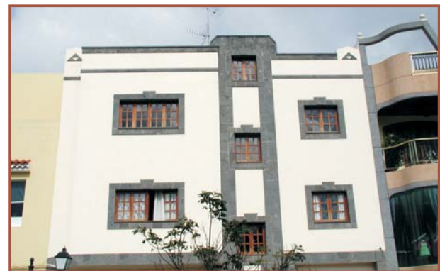
Foto 25.- Casa nueva de pisos en el casco con ventanas de cantería.
