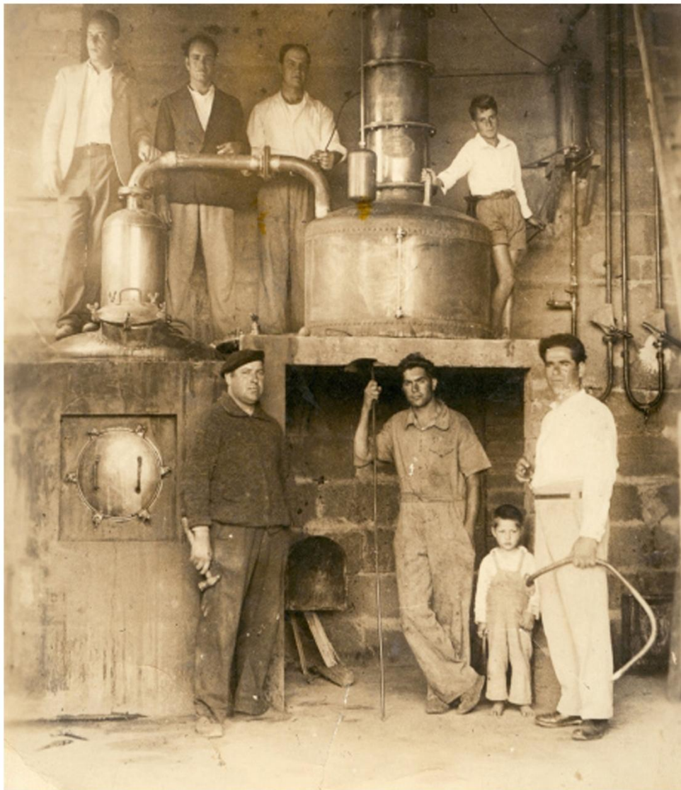
Alambique Savalle , modelo de 1870, que funcionaba a mediados del siglo XX en Fuencaiente, La Palma en la fábrica de Manuel Díaz Duque (imagen de Juan Carlos Díaz Lorenzo, 2011)
