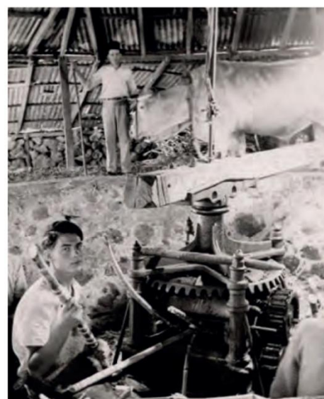
Interior del molino accionado por bueyes, tipo americano de fundición y malacate. Año 1950.
