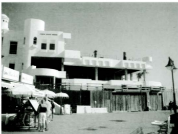
Vistas de la edificación de antes Casa Reina 2010.
