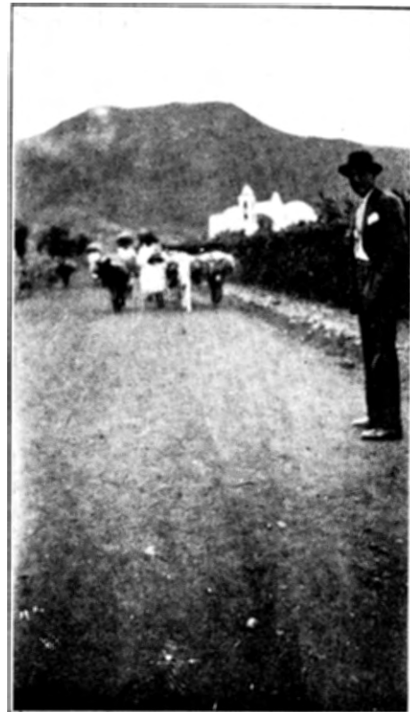
Carretera en Santiago del Teide.
