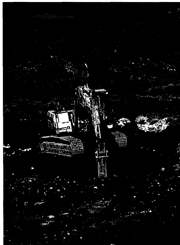
Figura 40. Proceso de excavación de la charca artificial de Agaete (obra en curso, proyecto ref. 5).
