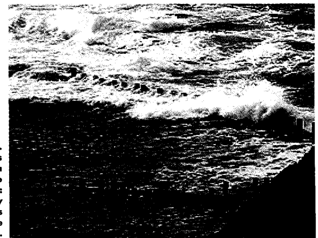
Figuras 34 y 35. Hilera de cilindros de seguridad en la charca de Roque Prieto: amortiguación y dispersión de los flujos de rebase de las olas.
