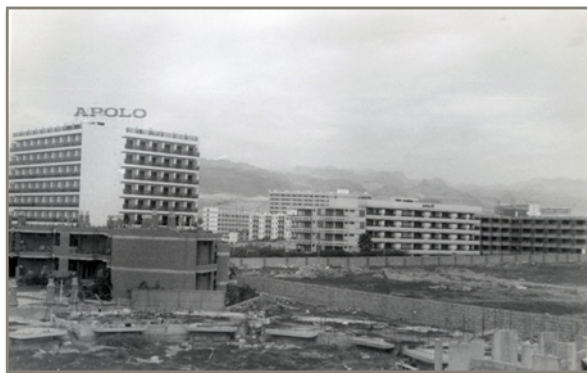
Figura 7. Construcción de hoteles en el sur grancanario, 1976.
