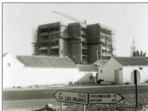
Figura 8. Edificio Mercurio en obras, 1971.
