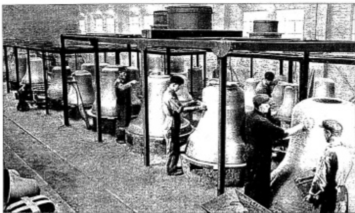
Cedera de pulido de las campanas, una vez concluida la fundición.
