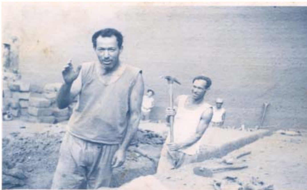
Pedreros realizando las labores de rozo
