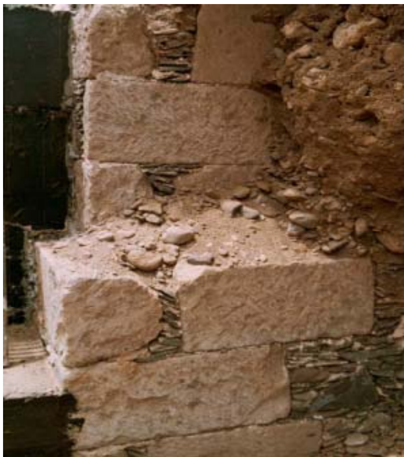
Soporte lateral de las bóvedas del Puente de los Tres Ojos
