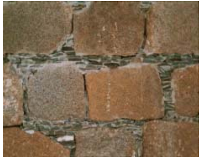
Ripio con lajas de piedra viva Muro del monumento a los canteros
