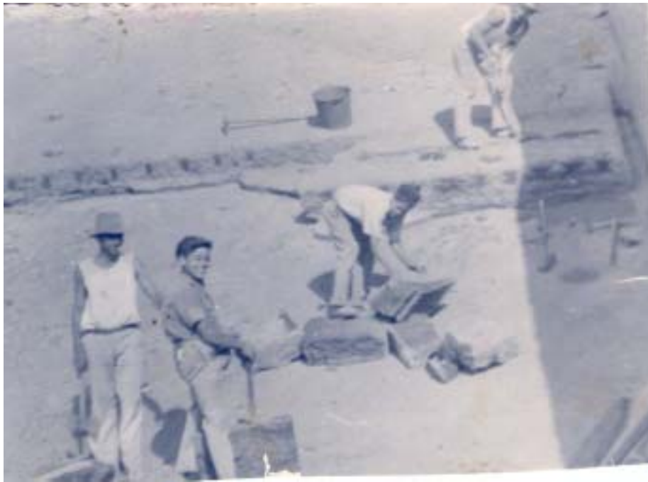
Pedrerros en el interior de una cantera. Cada miembro de la cuadrilla desempeña una labor determinada dentro del grupo
