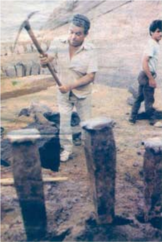
D. Manuel Tacoronte, destacado cantero y formador de jóvenes pedreros.
