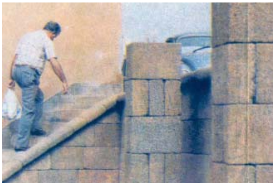
Escalera y marquesina realizadas en cantería
