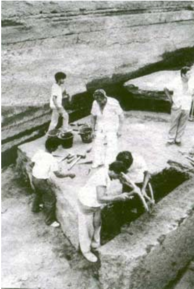
Banco de piedra ya cuartelado dispuesto para ser desprendido
