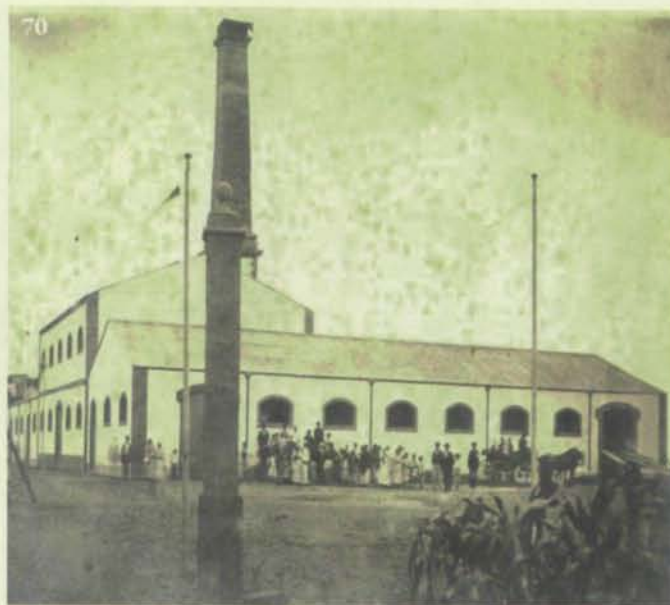
70. La fábrica de azúcar de San Pedro en torno a 1900. Museo de las Destilerías de Ron Arehucas.
