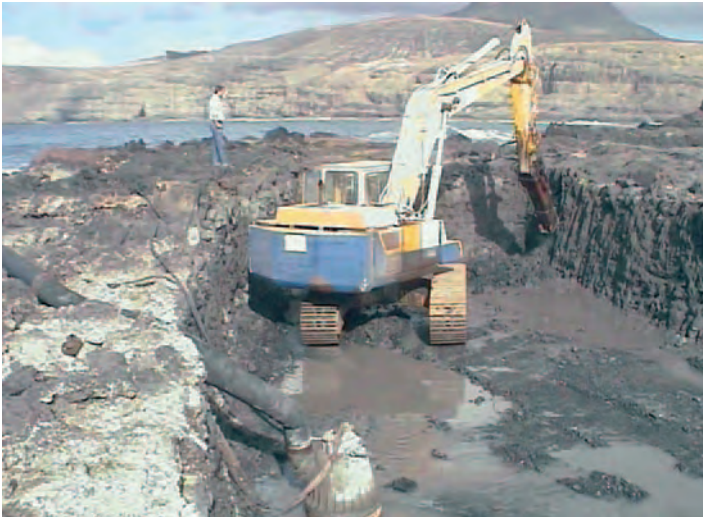
Fig. 8. Perforación de uno de los túneles del recinto exterior grande (18-12-2003)
