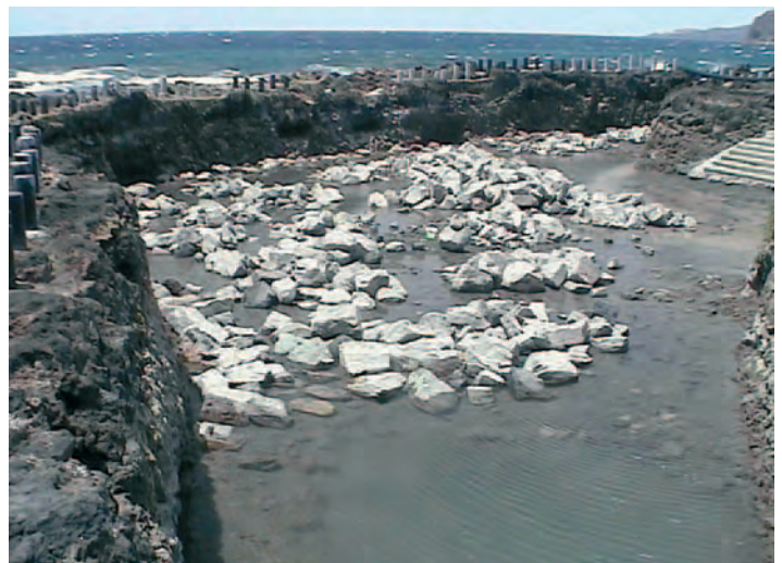
Fig. 13. Montículos de grandes piedras en el recinto exterior grande (15-07-2005).
