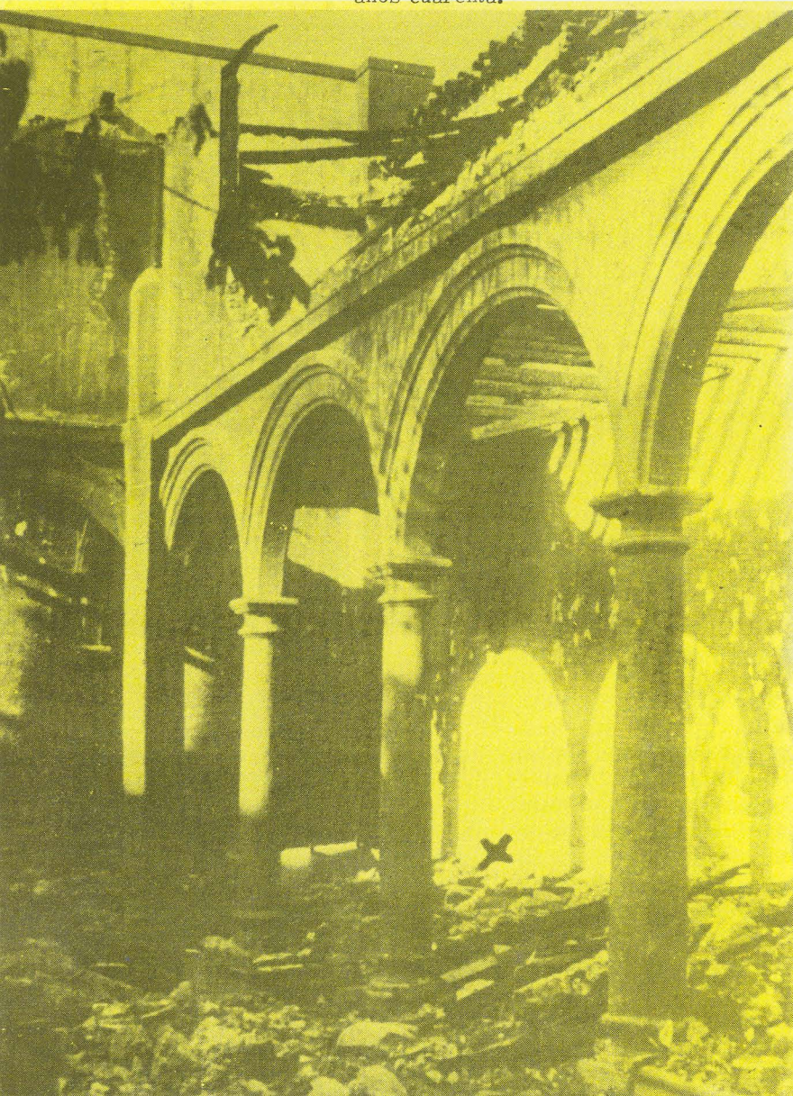
Arquería de piedra del claustro del antiguo convento. El edificio en estado ruinoso -se había incendiado en 1931- fue derribado en los años cuarenta.
