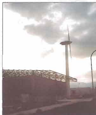
Foto 3.10.— Aerogenerador conectado a la red (Gran Canaria)
