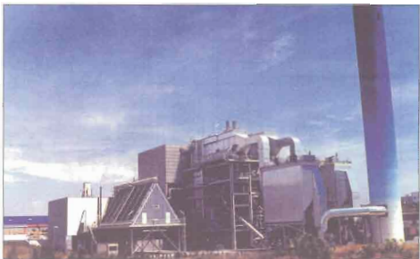
Foto 3.33.— Planta incineradora de Tarragona.
