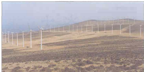
Foto 3.5.— Parque eólico Cañada del Río (Fuerteventura)
