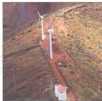
Foto n.º 1- Aerogeneradores de Valverde
