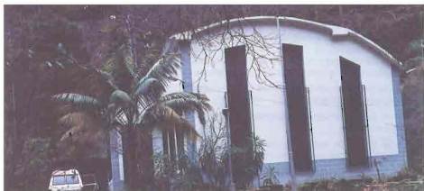
Foto 2.7.— Central hidroeléctrica de El Mulato (La Palma)
