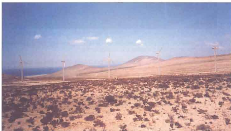
Foto 3.3.— Parque Eólico de Costa Calma (Fuerteventura)
