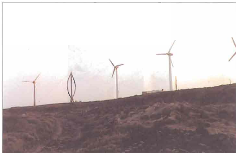
Foto 3.4.— Plataforma eólica del ITER con diferentes tipos de aerogeneradores (Tenerife)
