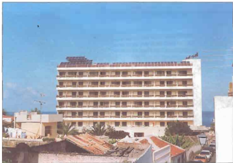
Foto n.º 1 - Instalación solar B.T. en el hotel Majec Park
