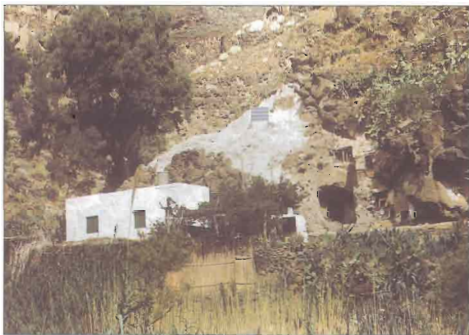
Foto 3.22.— Instalación electrificación rural fotovoltaica (Gran Canaria)
