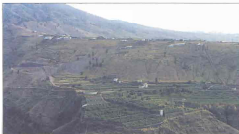
Foto 4.6.— Central hidroeléctrica de Argual (Fuera de servicio) (La Palma)
