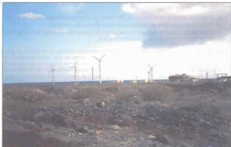
Foto 3.7.— Instalaciones eólicas de Arinaga (Gran Canaria)
