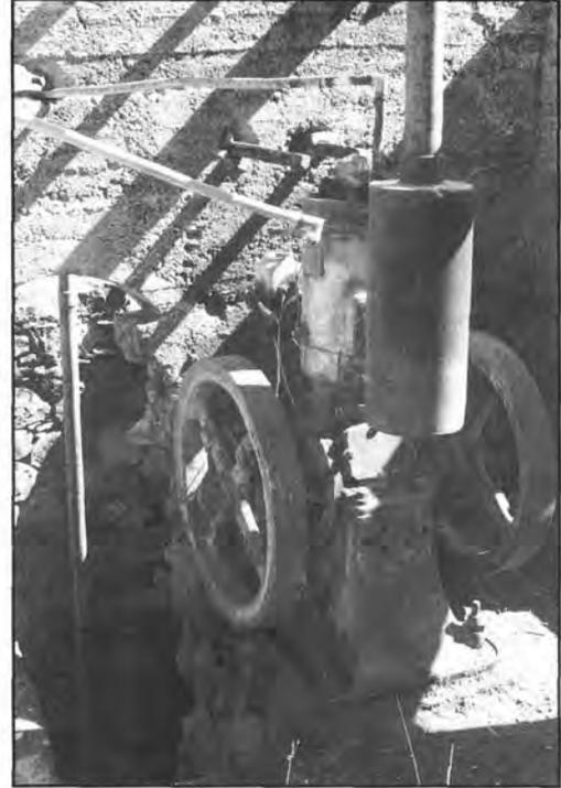
Fig. 3. *Dixi-Roholmotor* de la casa alemana Waggonfabrik. Un motor de dos tiempos, de bulbo caliente, de potencia 12 C.V.; el primer motor de gasoil instalado en La Aldea, por Hermenegilgo Saavedra, en el año 1923.
