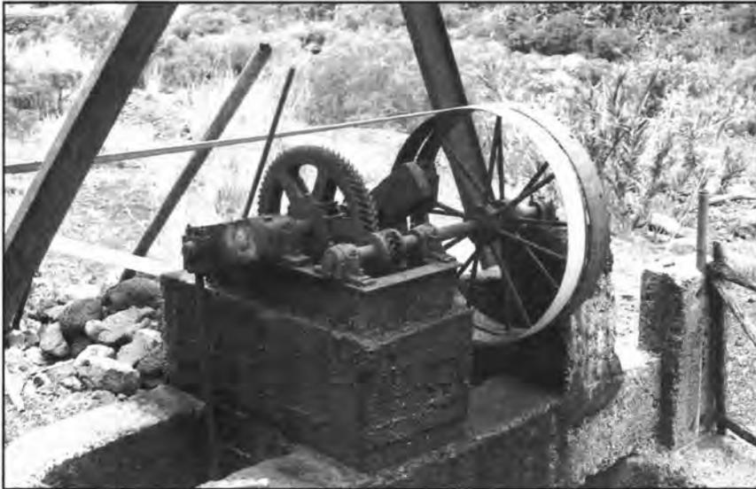
Fig. 13. Cabezal de dos cuerpos, fabricado en los talleres de Las Palmas de Gran Canaria, con engranajes en V, para accionar dos bombas de pistón que se generalizó en los años 50 en pozos con niveles piezométricos de 20 a 40 metros.
