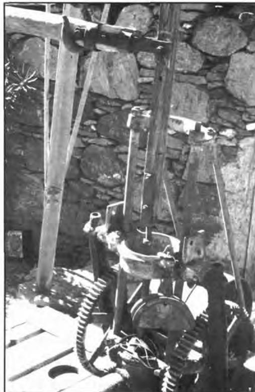
Figs. 6 y 7. Tres sistemas de achique en un pozo de La Cruz de la Cañavera (La Aldea) acoplados a una bomba de pistón. Mecanismos de superficie: Fig. 6. El aeromotor con su varilla en sincronía con una palanca para el bombeo manual y con un cabezal accionado por un pequeño motor auxiliar; Fig. 7. Detalle del acoplamiento.
