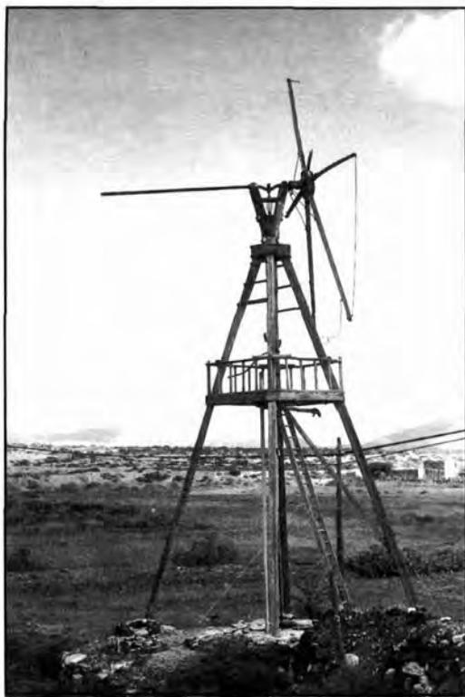
Fig. 2. *Molino del país. Modelo arcaico muy extendido en Fuerteventura. Estructura de madera, transmisión de cigüeñal forjado en el eje de transmisión y rotor de velas.*
