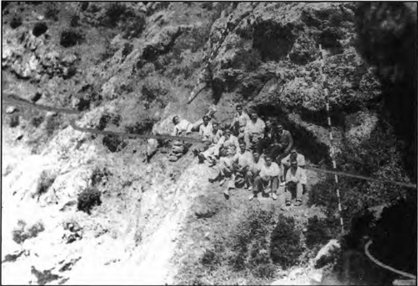
Fig. 4. *El paso de El Andén Verde. 1929-1930. Fotografías tomadas en los trabajos del trazado de la carretera e insertadas en la Memoria del proyecto del Trozo 4.º. Los ingenieros redactores (Fig. 3) y todo el personal facultativo de Obras Públicas (Fig. 4) tuvieron que realizar los trabajos prácticamente colgados en estos acantilados.*
