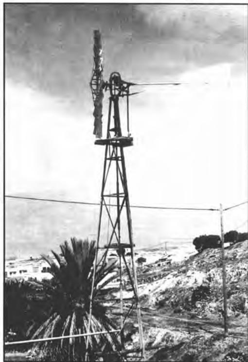
Fig. 3. Molino americano de marca **Dandy**, instalado en el Valle de Santa Inés, Fuerteventura, en el año 1914. Trasmisión por cigüeñal con coronas de desmultiplicación, sin cárter. Rotor de 12 pies.
