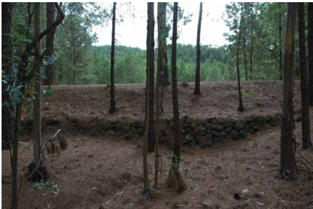
Figura 12. La Laguna. Muro y caballón de tierra (arcilla)
