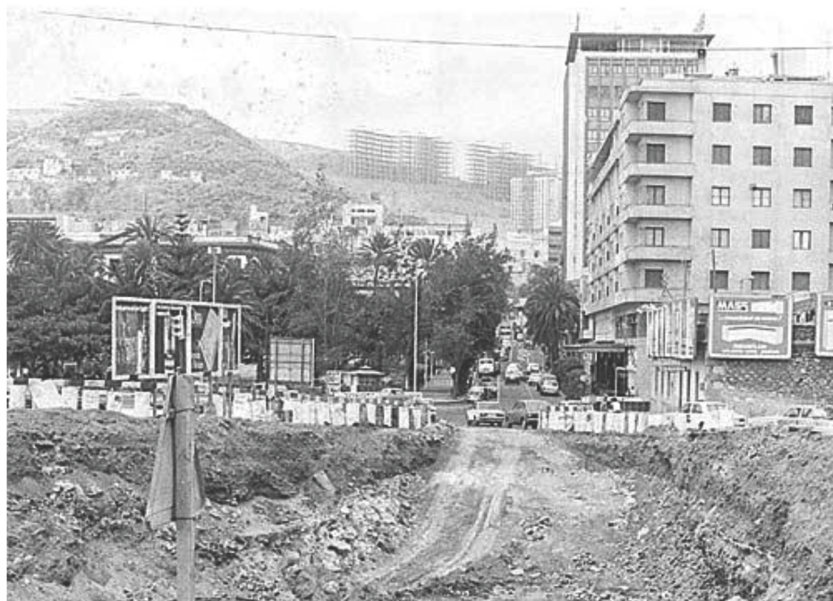
El inicio de las obras de la estación. Archivo Hotel Parque .
