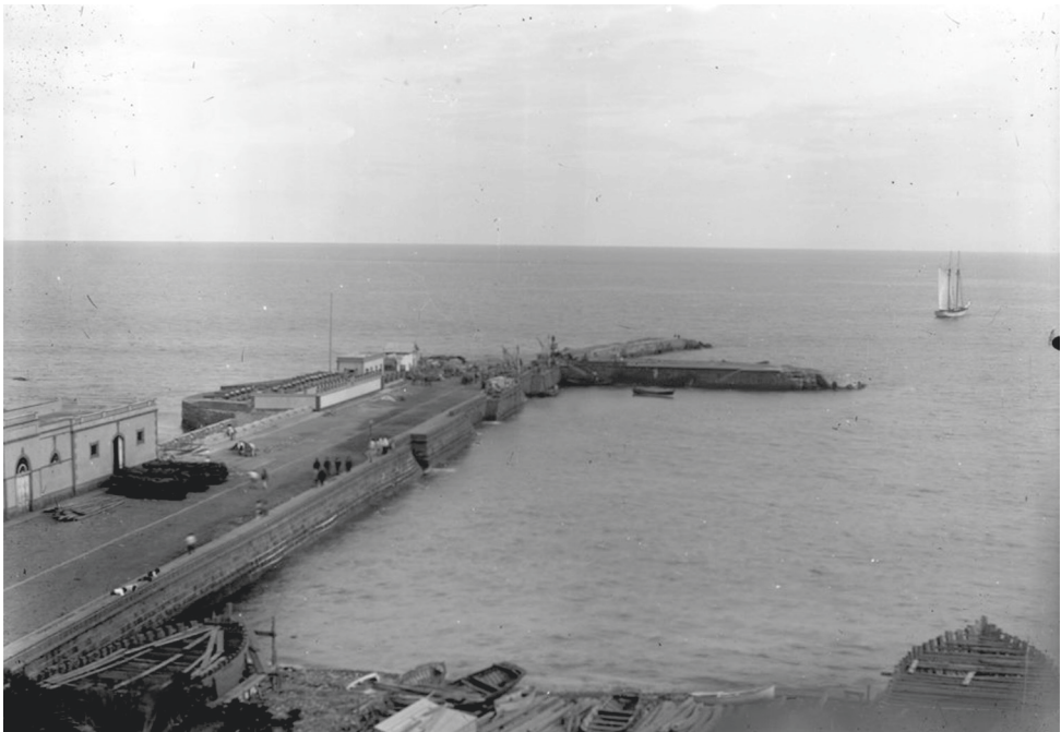
Es un buen día de mar. Se puede apreciar que el dique del naciente aún no está finalizado y el “martillo” tampoco. Botes y deterioradas barcazas en la orilla. Colección Domingo Doreste.
