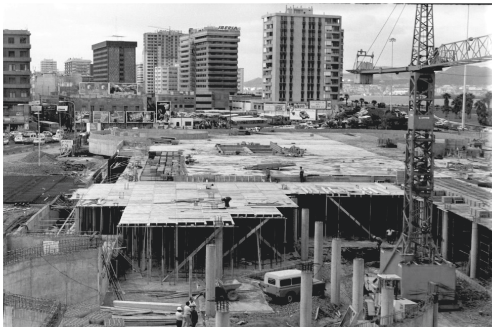
Las obras avanzan. Se observa, sobre la cubierta, al fondo, una serie de guaguas ubicadas en un aparcamiento provisional. Archivo Hotel Parque .
