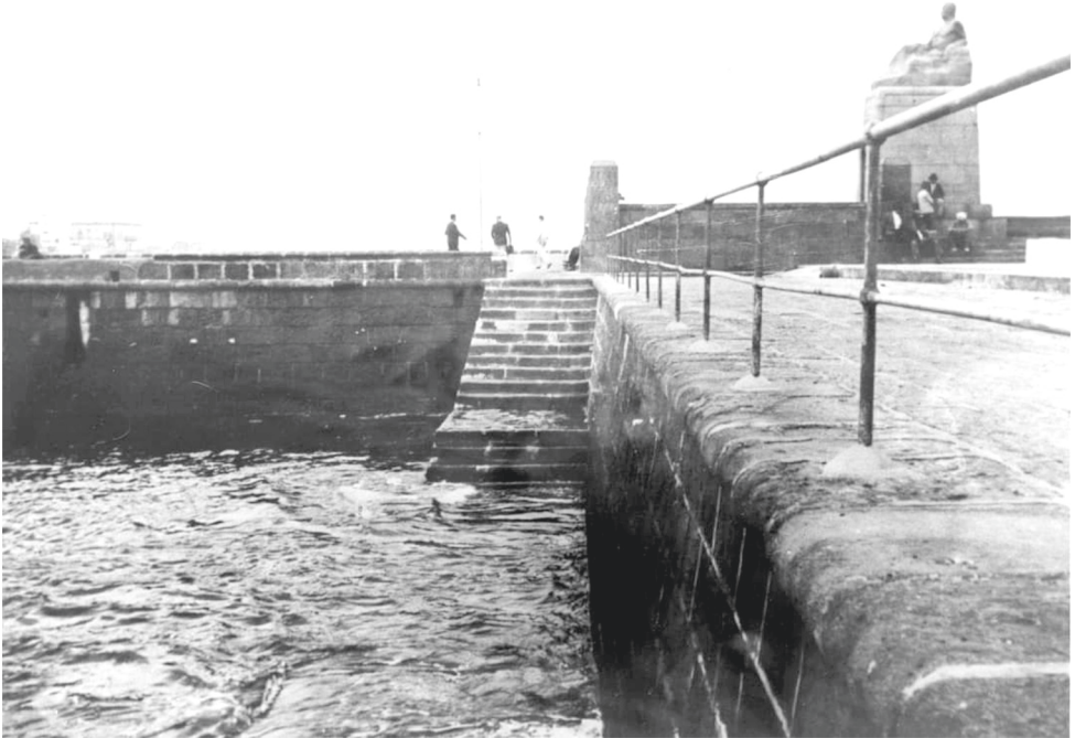
Un aspecto del muelle en el cruce con el “martillo” (andén corto y vertical al principal) y Galdós, mirando a la Ciudad, en el cruce de los andenes. De autor desconocido. Archivo Enrique Pérez.
