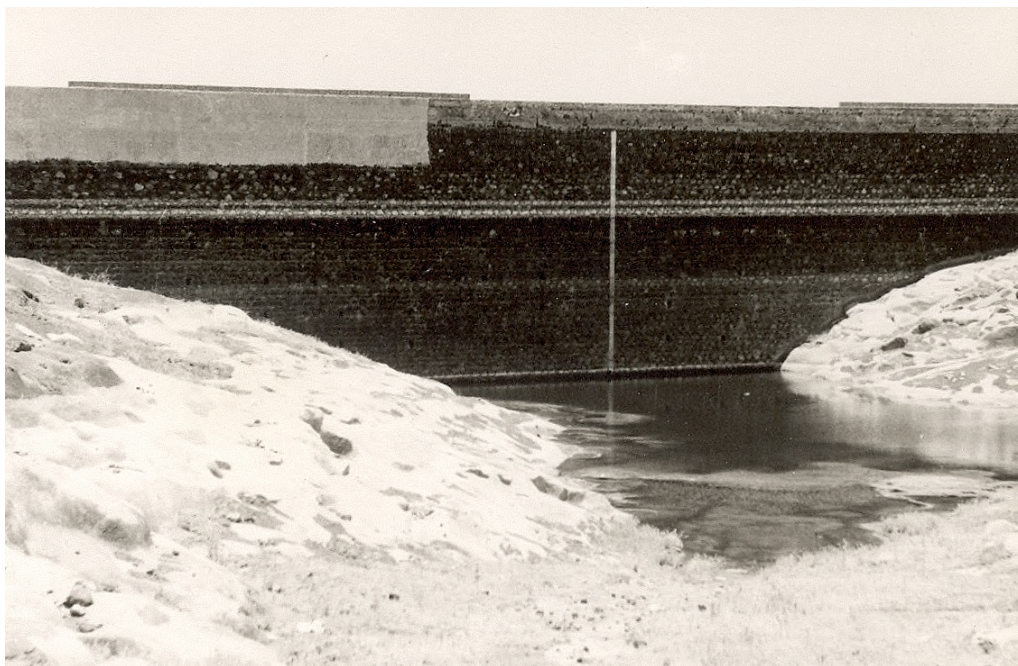
Figura 3; Vaso impermeabilizado, charco de agua y muro de presa (SGOP)
