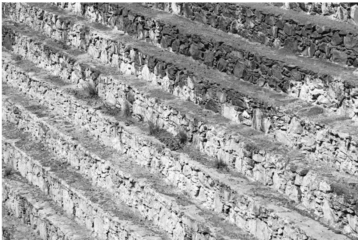
Figura 9; Detalle del escalonado del talud de aguas abajo (J. González, 2012)
