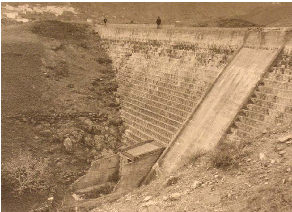
Figura 5; Visita de los técnicos a la presa en 1971 (SGOP)
