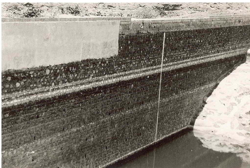
Figura 10; Detalle del talud de aguas arriba (SGOP)
