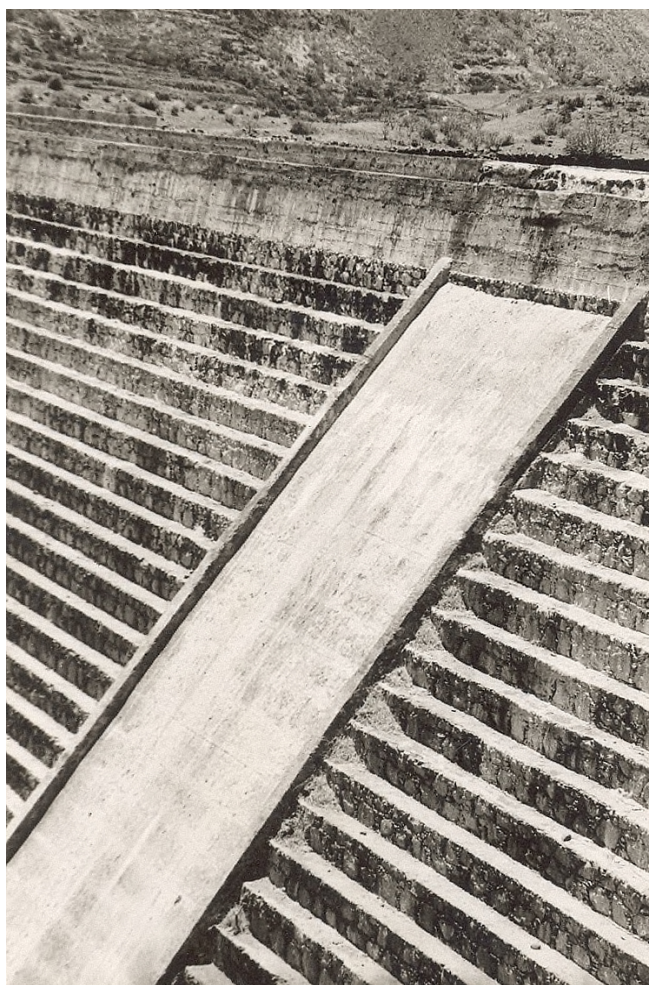
Figura 4; Detalle del talud de aguas abajo (SGOP)
