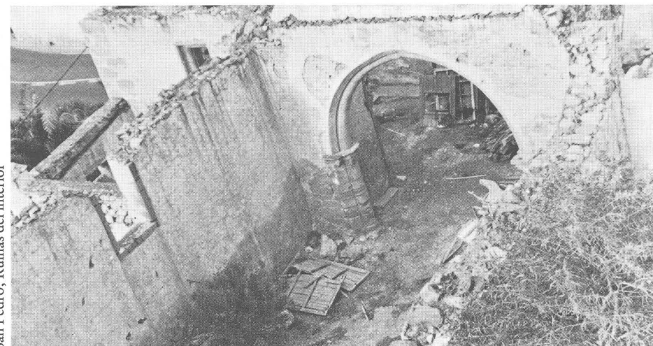
San Pedro, Ruinas del interior
