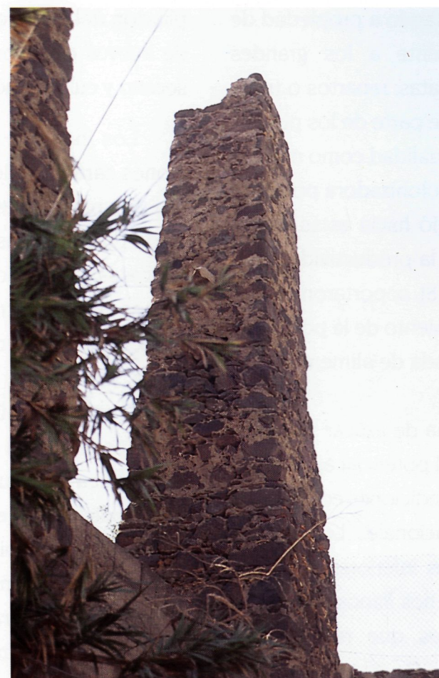
Los ingenios de azúcar fueron industrias agroalimentarias características del paisaje del siglo XVI. Sus principales instalaciones fueron la casa de purgar, la casa del ingenio, el molino y las casas de los esclavos. Los Picachos, Telde.
