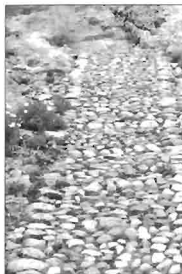
Foto 15. Empedrado con dos maestras laterales y varias transversales. Camino de la Plata.
