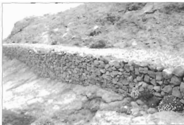
Foto 13. Detalle de muro de piedra seca y empedrado sobre roca. Paso de La Plata.
