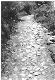
Foto 16. Empedrado con una maestra lateral sujetando el borde del camino. Camino de Las Vueltas de Acero, Moya.
