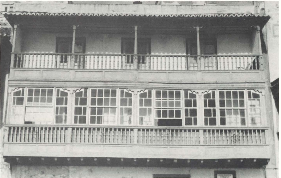
Solanas, la inferior cubierta recientemente con ventanas corredizas (Santa Cruz de la Palma).
