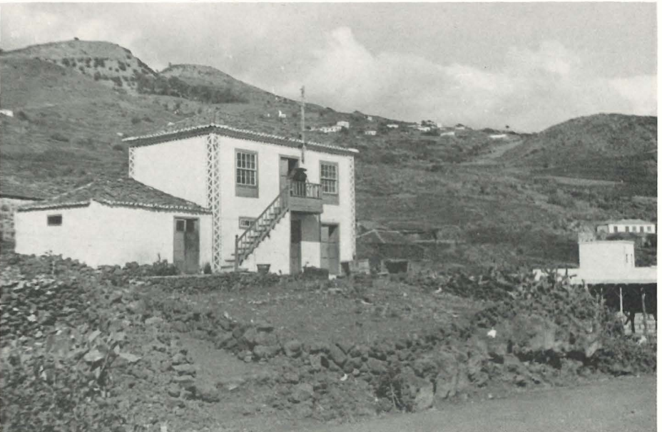
Casa con ventanas de guillotina y escalera exterior. La casa terrera inmediata es la cocina. (Hoyo de Mazo. La Palma).
