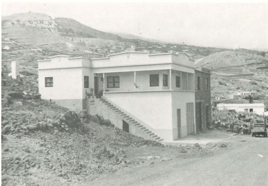
Casa reciente con escalera lateral (Hoyo de Mazo. La Palma).
