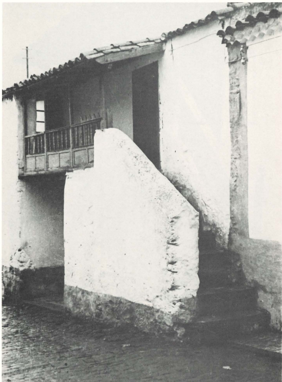
Casa con escalera exterior de mampostería. (Moya, Gran Canaria). (Foto Naranjo.)
