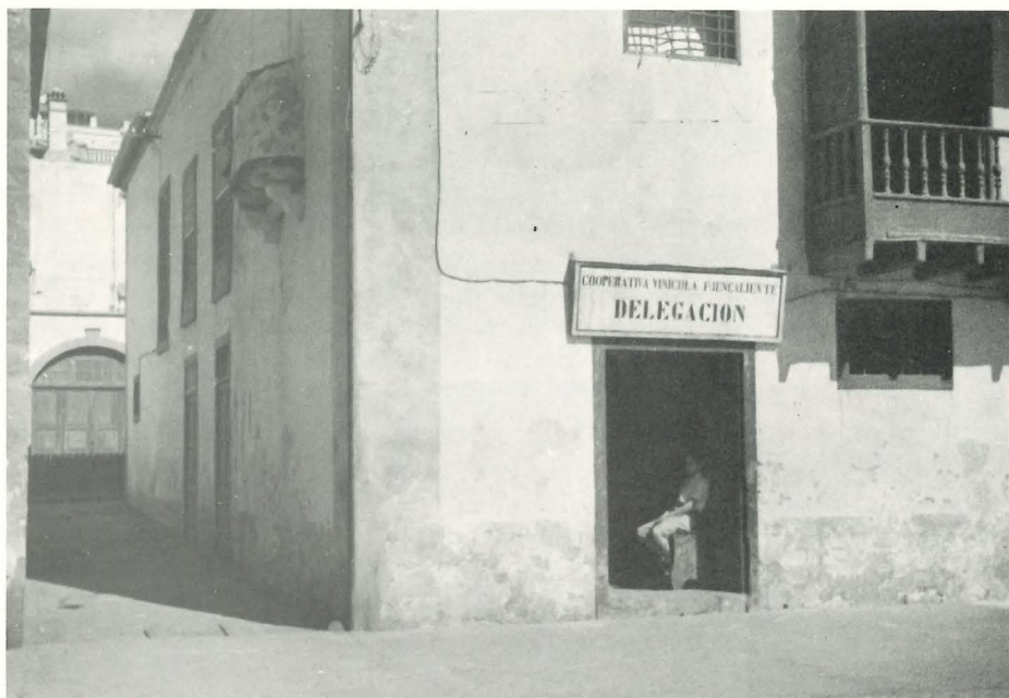
Otro horno saliente en pared lateral, a la altura del segundo piso (Santa Cruz de la Palma).
